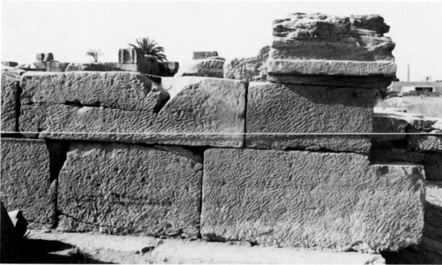
◁ A. Podium, premier état, face nord, extrémité ouest : dévers des assises corrigé lors de la taille de la corniche (la corde indique l'horizontale).
