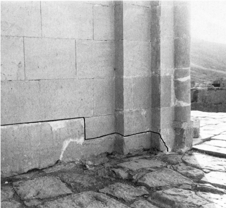
◁ Fig. 8. Vue sur la partie nord de l'entrée de la pièce construite au sud de la deuxième salle hypostyle. Le contour noir souligne le bloc original. Le tore vertical et le bloc d'angle ne sont pas originaux et ont été restaurés de façon erronée par Baraize.
