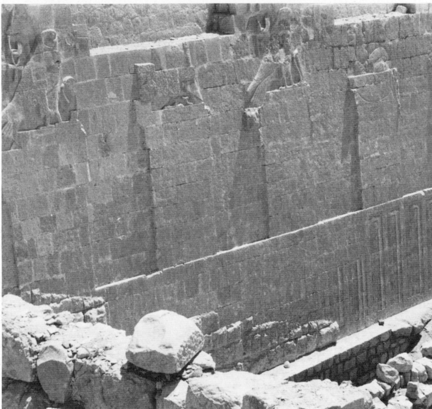
◁ Fig. 4. Vestiges du tracé de la première rampe. La diagonale est soulignée par un trait rouge et une différence entre les pierres parées (au-dessus de la rampe) et celles qui ne le sont pas (et qui correspondent à la rampe).
