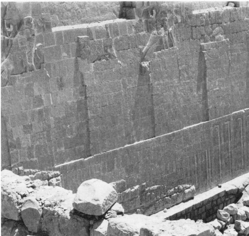
◁ Fig. 4. Vestiges du tracé de la première rampe. La diagonale est soulignée par un trait rouge et une différence entre les pierres parées (au-dessus de la rampe) et celles qui ne le sont pas (et qui correspondent à la rampe).
