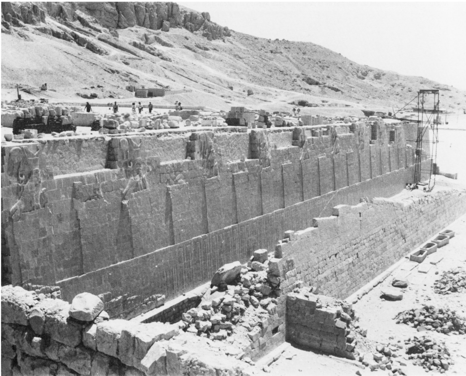
△ Fig. 9. Vue sur la face sud du mur de soutènement de la cour intermédiaire du temple. La différence de patine de la pierre correspond au tracé de la dernière rampe de la chapelle d'Hathor. Le mur de Montouhotep, couronné d'un parapet par Hatchepsout, s'élève vers l'ouest. Il bordait la rampe sur son côté sud.
