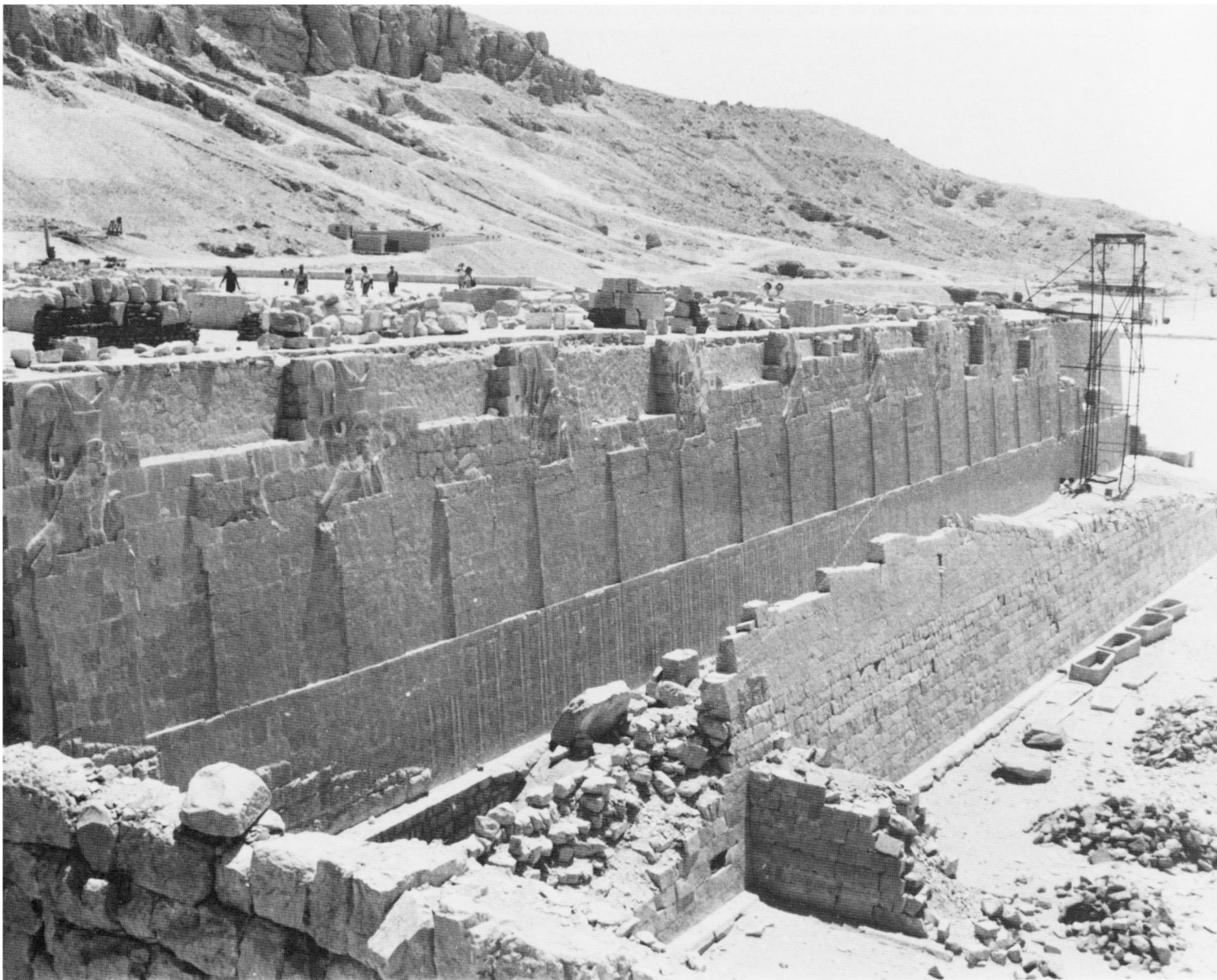
△ Fig. 9. Vue sur la face sud du mur de soutènement de la cour intermédiaire du temple. La différence de patine de la pierre correspond au tracé de la dernière rampe de la chapelle d'Hathor. Le mur de Montouhotep, couronné d'un parapet par Hatchepsout, s'élève vers l'ouest. Il bordait la rampe sur son côté sud.
