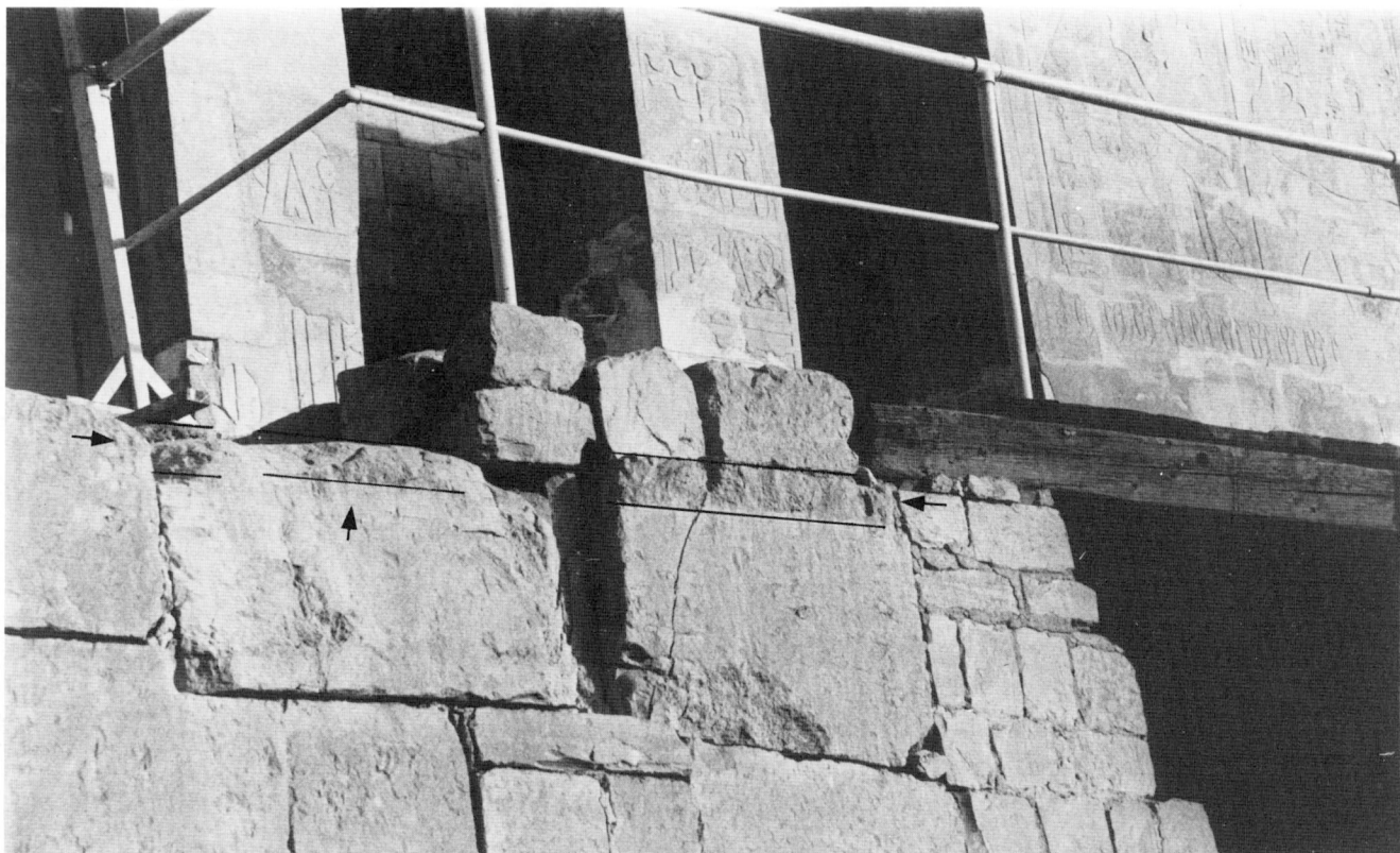
▽ Fig. 5. Vestiges du bord est de la deuxième terrasse. Le tore horizontal a été arasé lors de la construction de la troisième terrasse.
