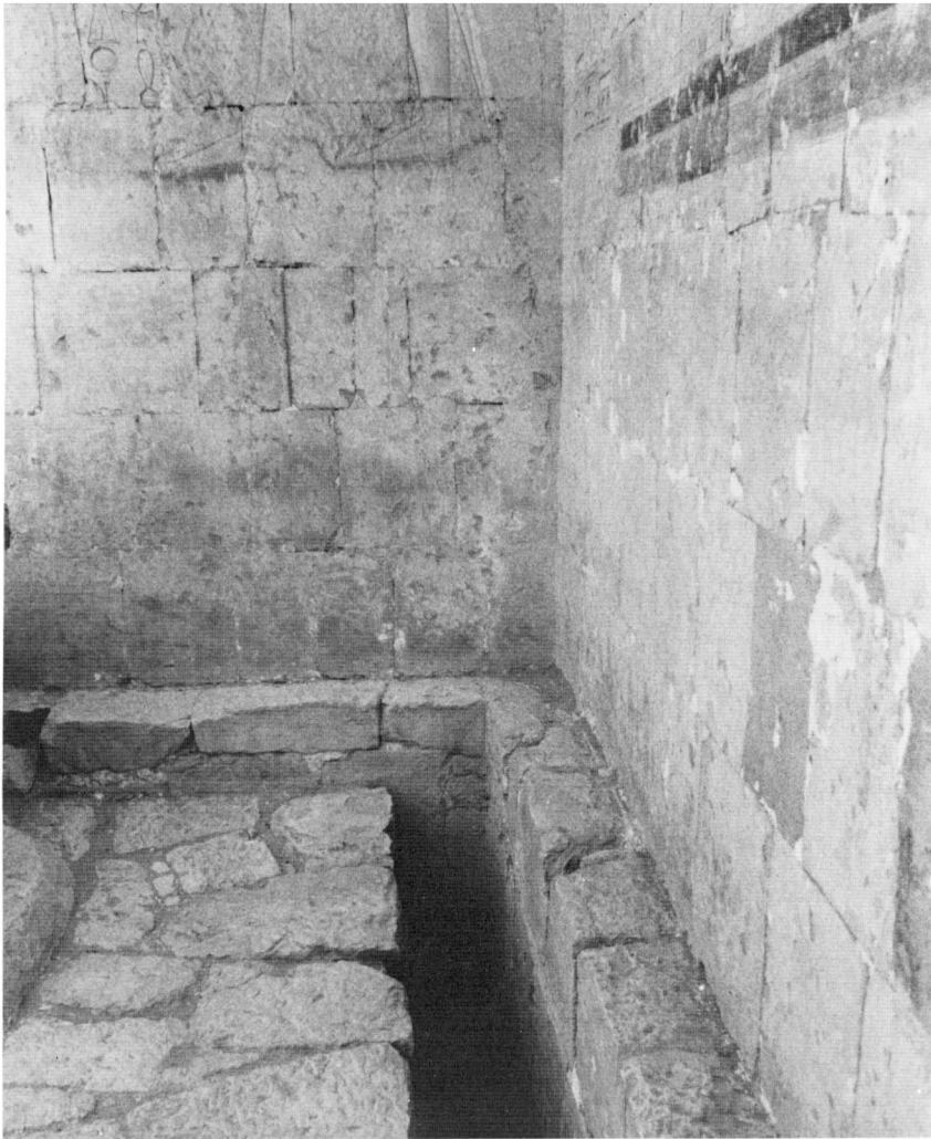
◁ Fig. 3. Coin nord-ouest de la seconde salle hypostyle : vue sur la partie nord de la première façade (face est), le mur nord qui sépare la chapelle d'Hathor du portique de Pount, le sol initial de la première terrasse (au fond de la tranchée) et le sol rehaussé lors de la construction de la seconde salle hypostyle.
