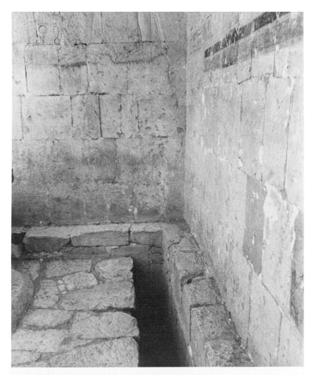
Sig. 3. Coin nord-ouest de la seconde salle hypostyle: vue sur la partie nord de la première façade (face est), le mur nord qui sépare la chapelle d'Hathor du portique de Pount, le sol initial de la première terrasse (au fond de la tranchée) et le sol rehaussé lors de la construction de la seconde salle hypostyle.
