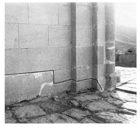
Sig. 8. Vue sur la partie nord de l'entrée de la pièce construite au sud de la deuxième salle hypostyle. Le contour noir souligne le bloc original. Le tore vertical et le bloc d'angle ne sont pas originaux et ont été restaurés de façon erronée par Baraize.
