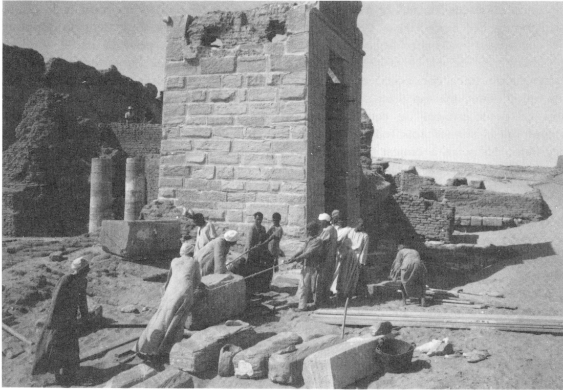
Fig. 8. Douch. Travaux de restauration de la porte de Trajan.
