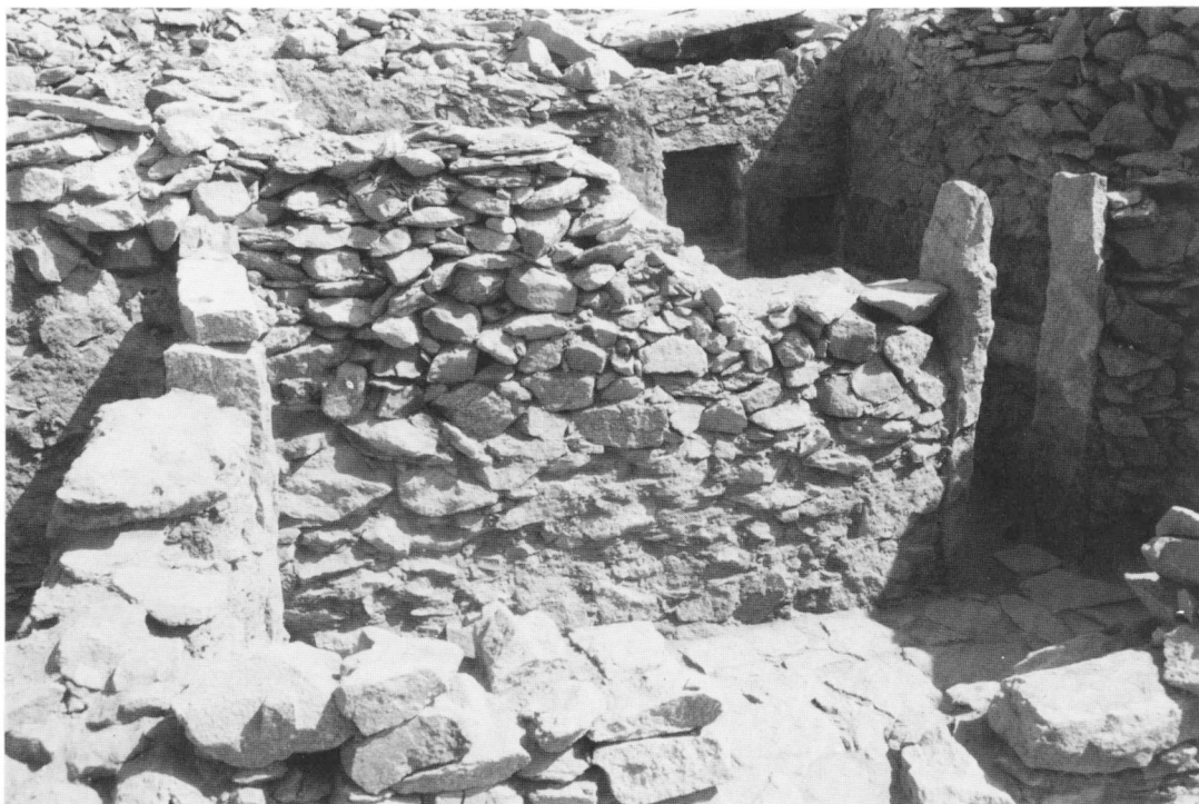
Fig. 14. Fort.W.I. L'antichambre dallée (Room 2). Au fond, la salle des peintures murales.
