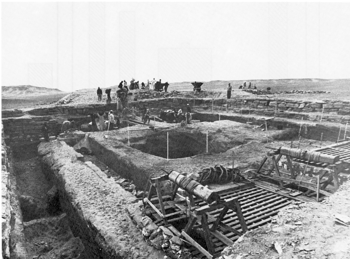
Vue de la tombe-puits depuis l'angle nord-est du mur d'enceinte.
