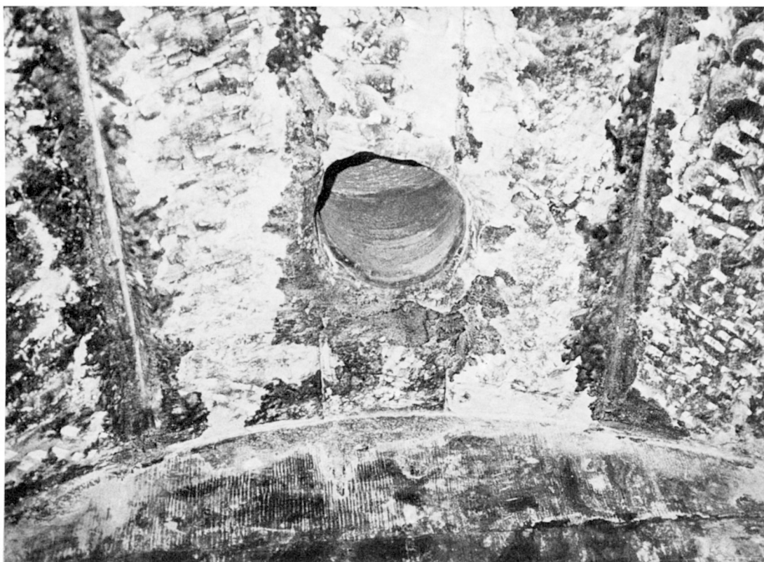
a. Détail d'une ouverture dans le plafond voûté de la chambre funéraire. Dans l'ouverture les restes du pot de blocage sont visibles.
