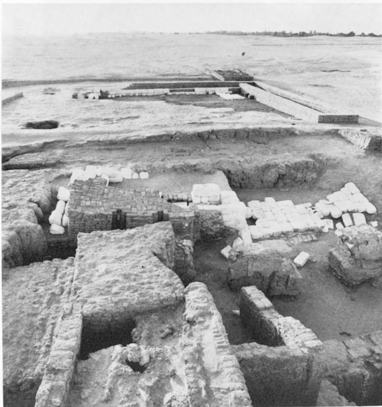
B. — Mastaba III, démontage et remontage de la chapelle.
