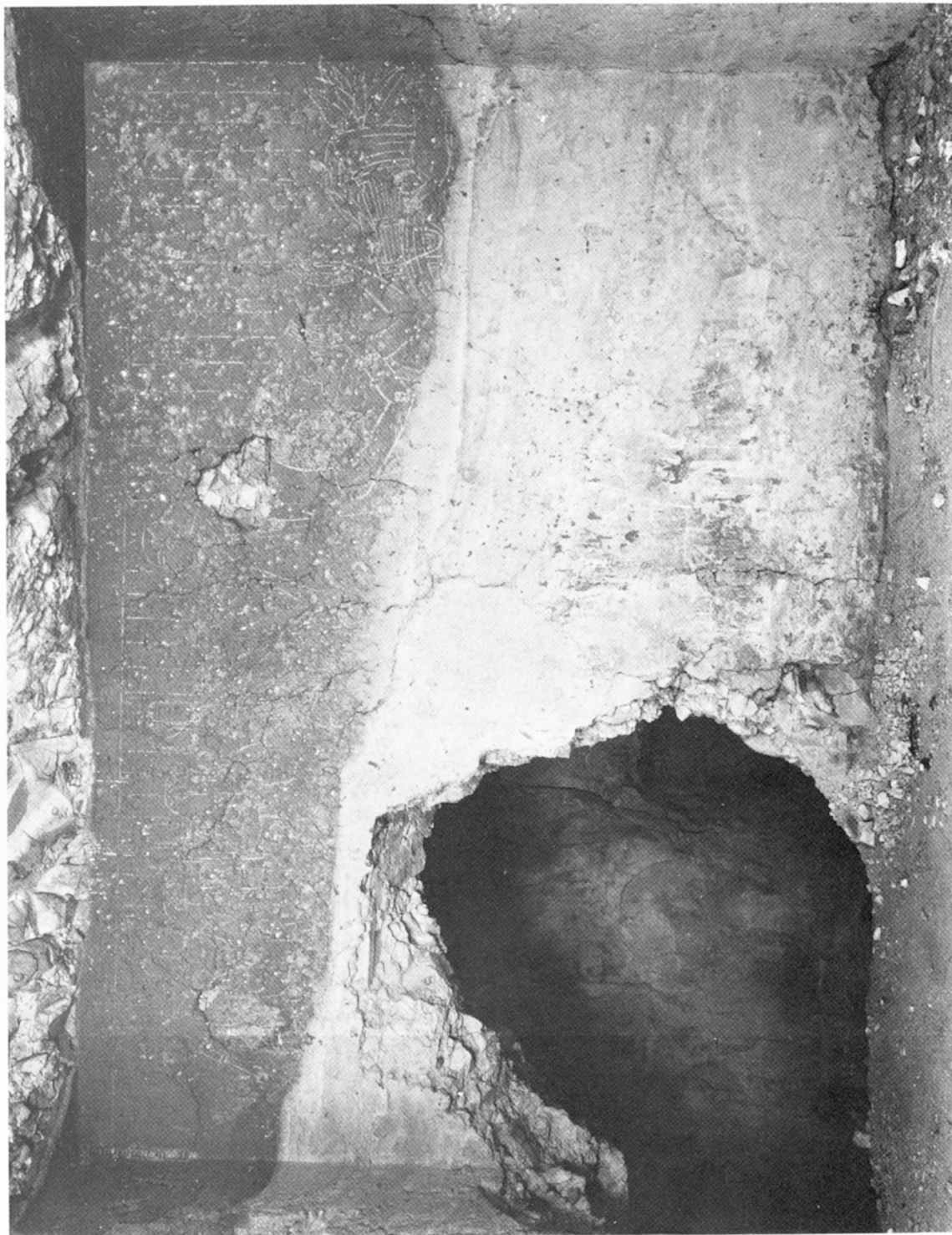
Chapelle à plafond plat (B) : mur sud.
