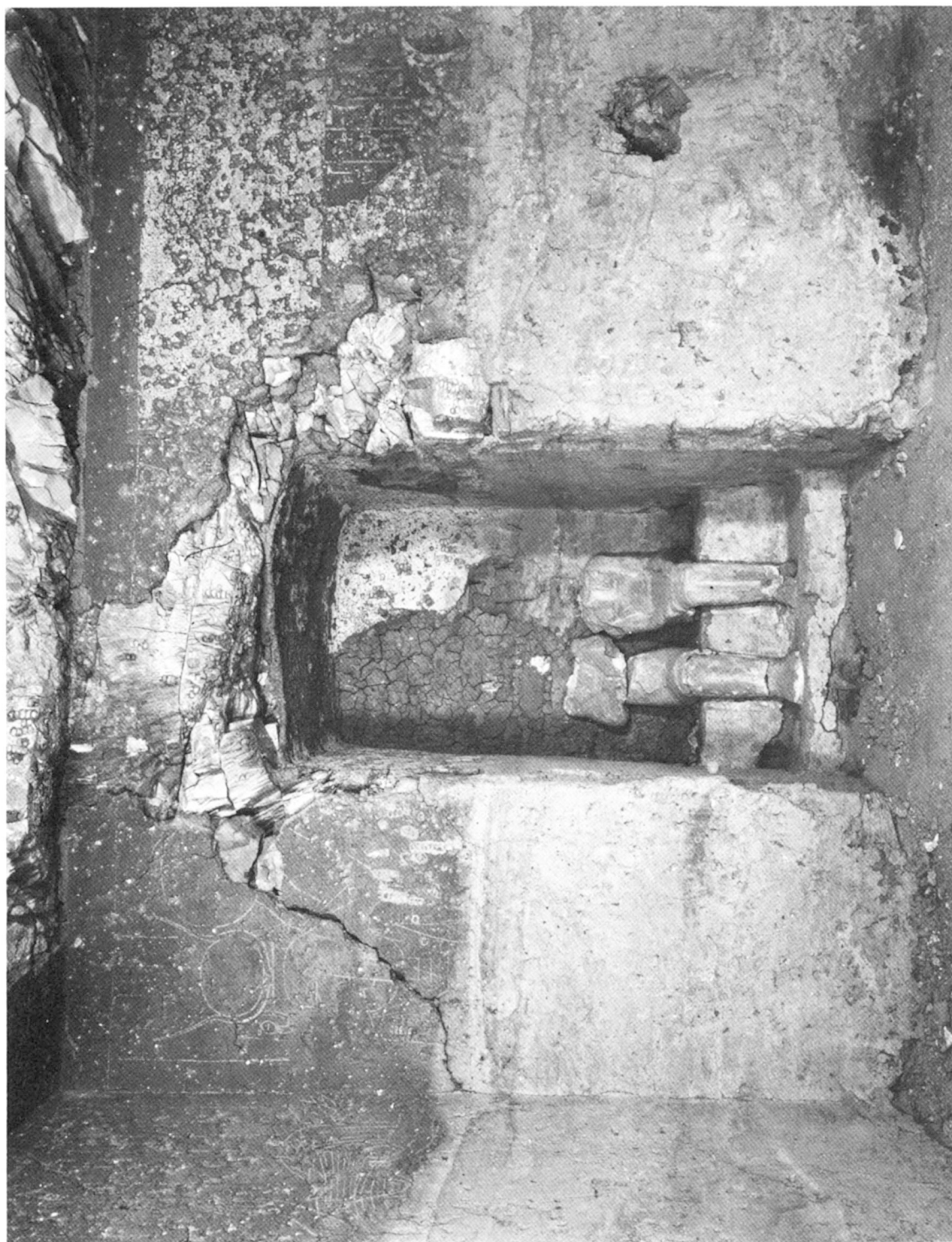
Chapelle à plafond plat (B) : mur ouest.
