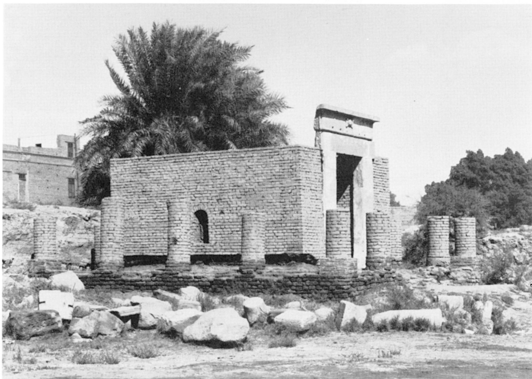
B. — Aspect général du monument vu du Sud (photo. A. Bellod).
