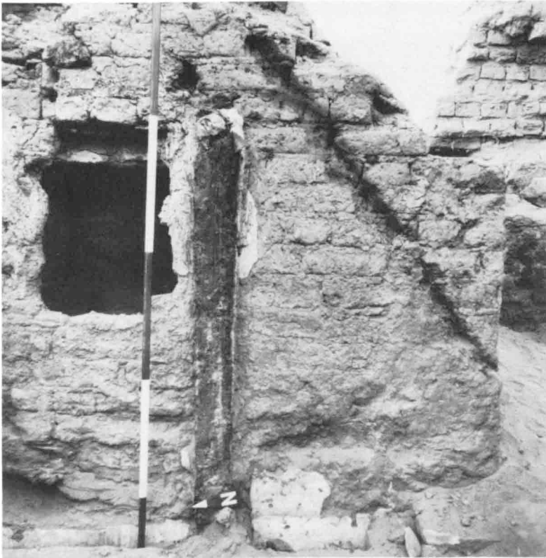
A. — Niche et huisserie de la porte de III et trace de l'escalier menant au premier étage.
