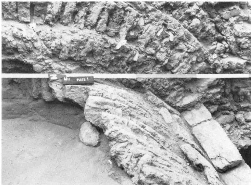
B. — Détail de la base de la voûte.
