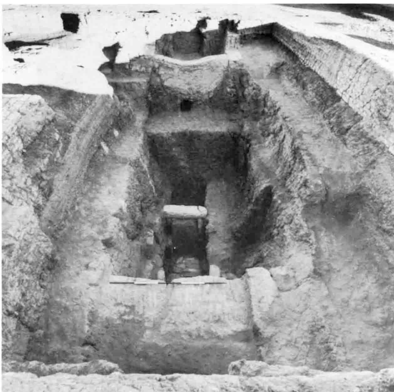
A. — Fouille de l'infrastructure avec la voûte du puits de construction, le couloir E.-O. et l'encadrement de porte (Cliché J.-F. Gout).
