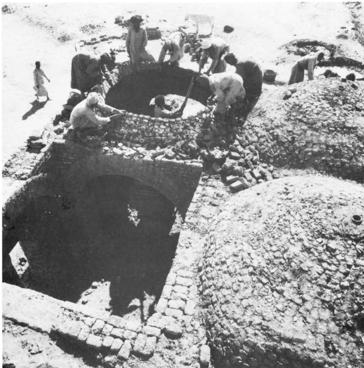
Construction d'une coupole, détail.
