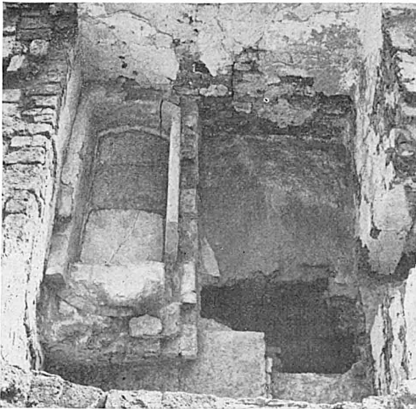
30. Caldarium (V), vue générale prise de l'ouest avec le bain et le conduit de vapeur.
