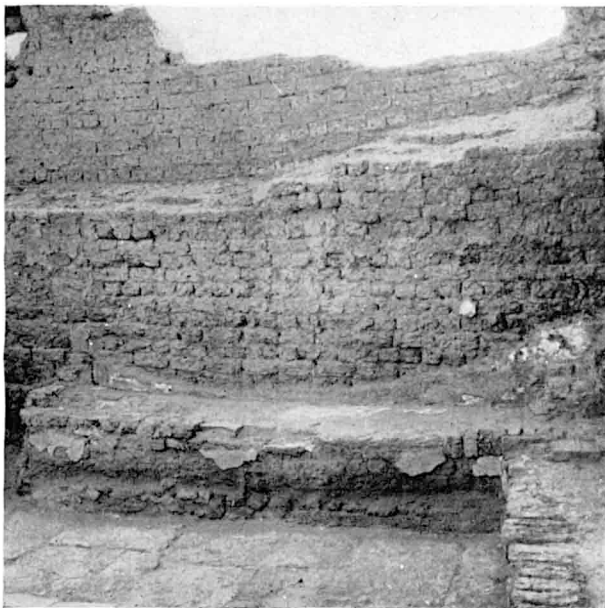
7. Salle I, mur est.
