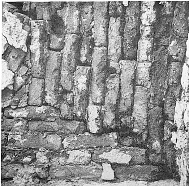
22. Tepidarium (III), coupole vue de dessous, détail de l'assemblage des briques.
