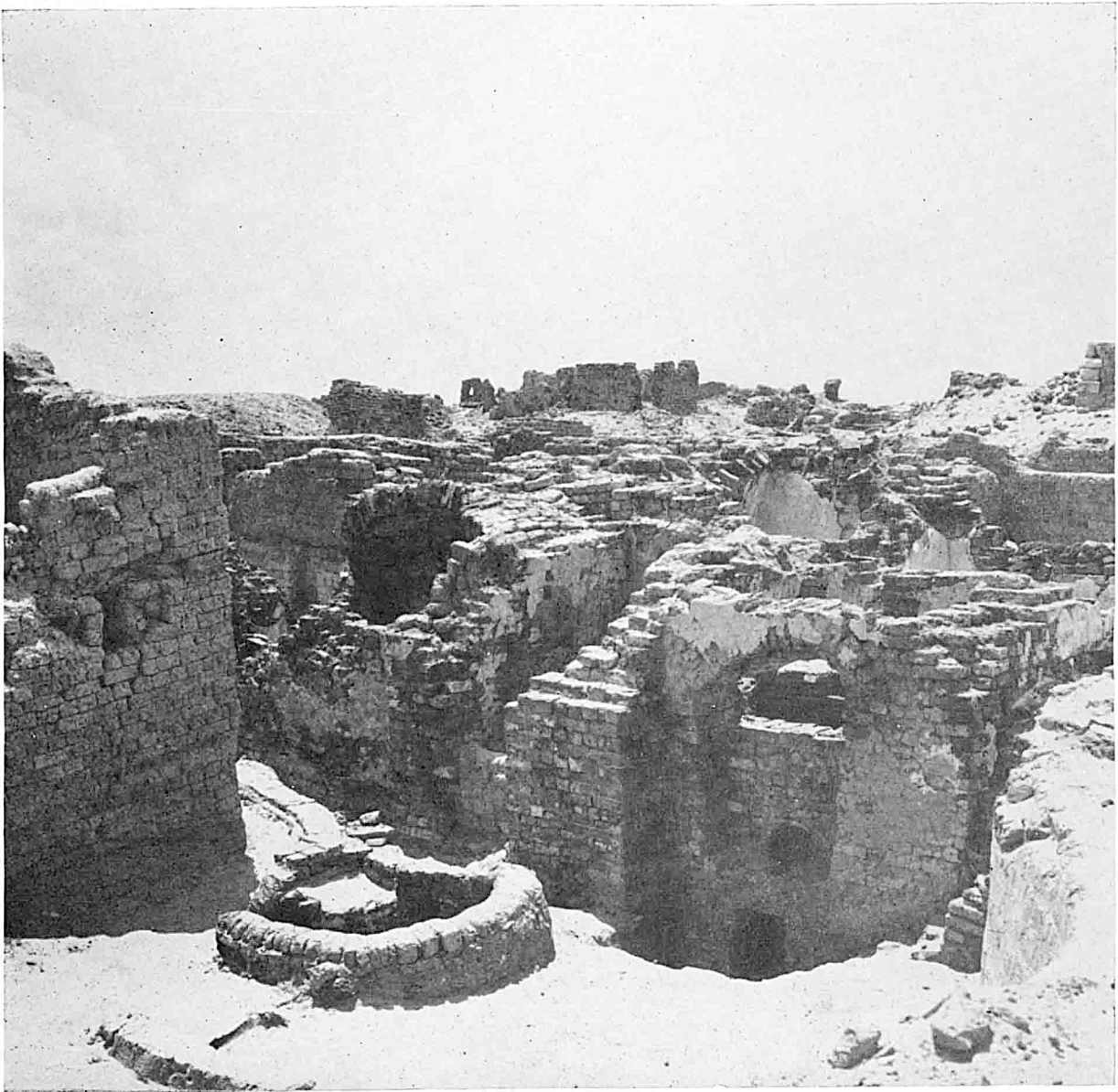
35. Chaufferie (VI), annexe de la chaufferie (VIII) et puits perdu vus de l'angle nord-est de la cour.
