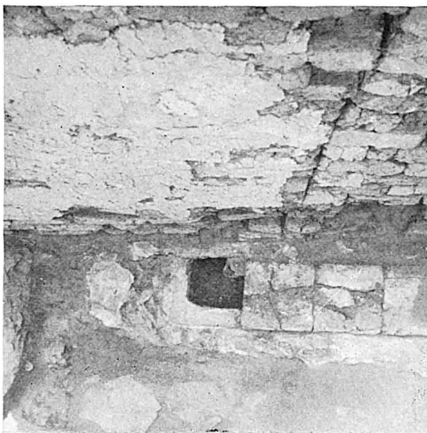
43. Corridor est, coude de la canalisation provenant du frigidarium (II).
