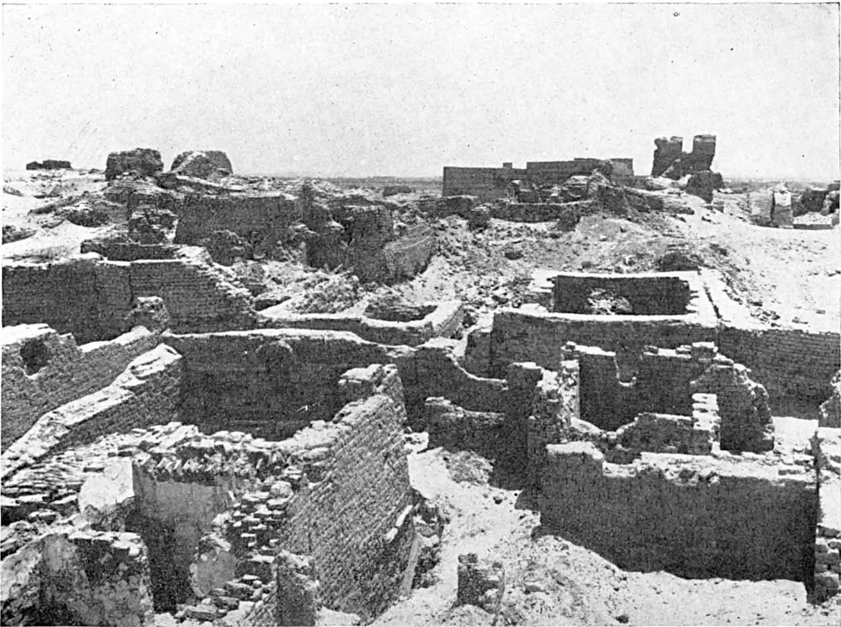
1. Vue générale du site prise du nord-ouest. Les bains sont situés à la partie inférieure gauche du cliché.
