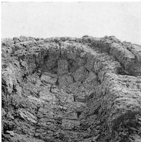
9. Salle I, mur sud, niche centrale, détail de la semi-coupole.
