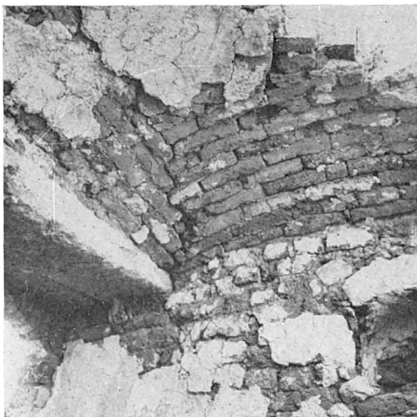
20. Tepidarium (III), coupole vue de dessous, angle nord-ouest.
