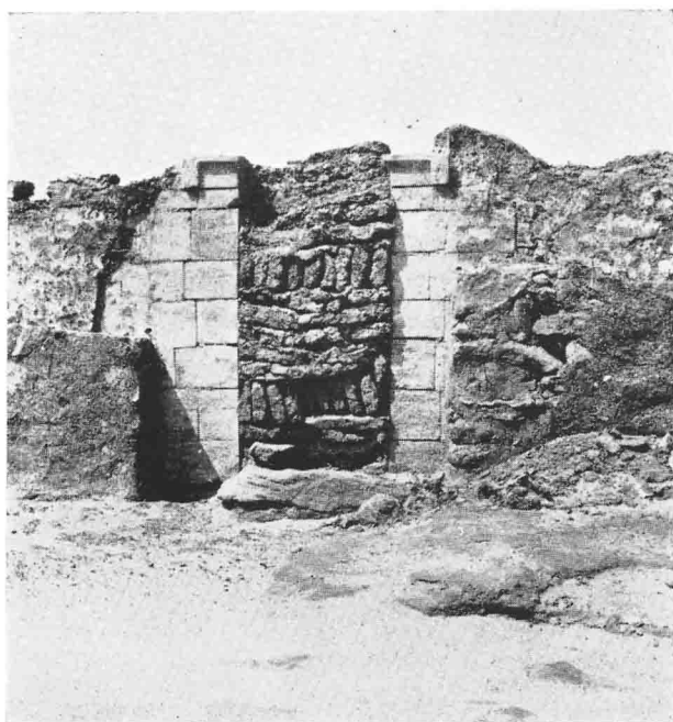
A. — Porte obstruée, entre I et D.
