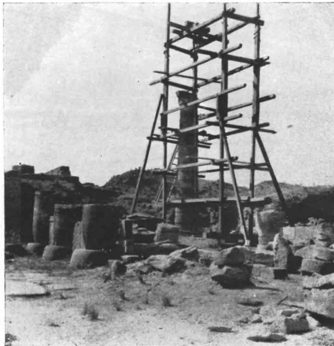
B. Anastylose de la colonne 20 (printemps 1952).
