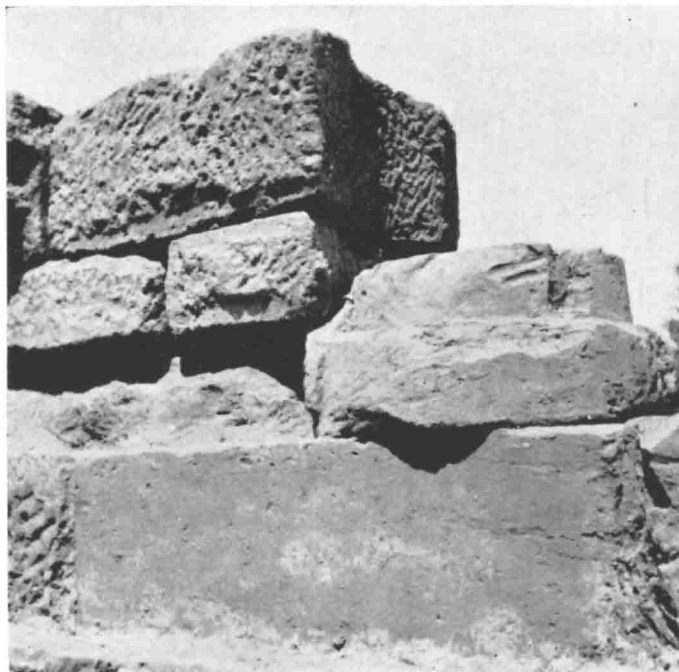
b. — Accroche du mur d'entrecolonnement est du kiosque romain.
