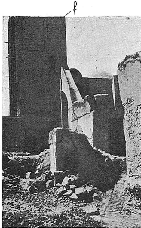
Fig. 4. — Ancienne mosquée (2 e époque). Ruine du mihrāb.
