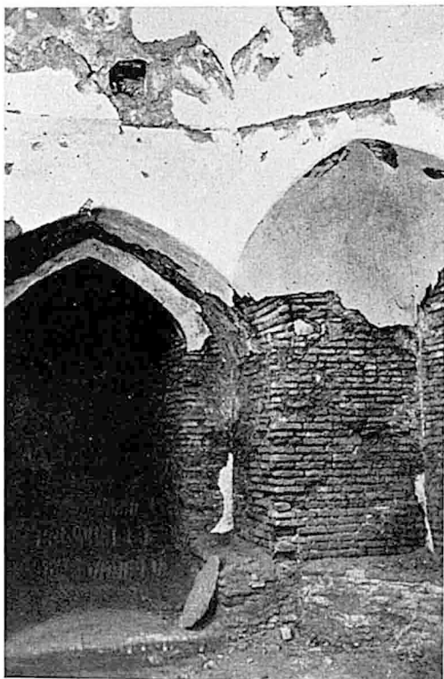
3. — Salle d'ablution souterraine.
