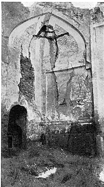
Fig. 13. — Angle S.-E. de la salle à coupole.
