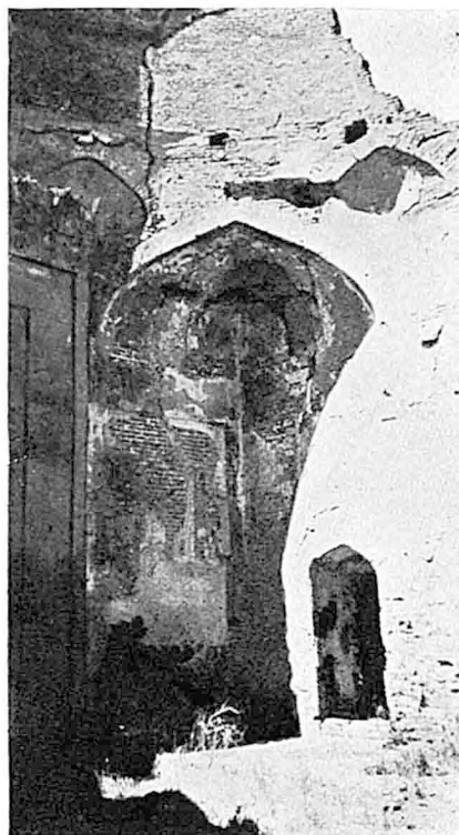
Fig. 14. — Angle S.-O. de la salle à coupole.
