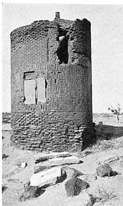
Fig. 16. — Base du minaret.
