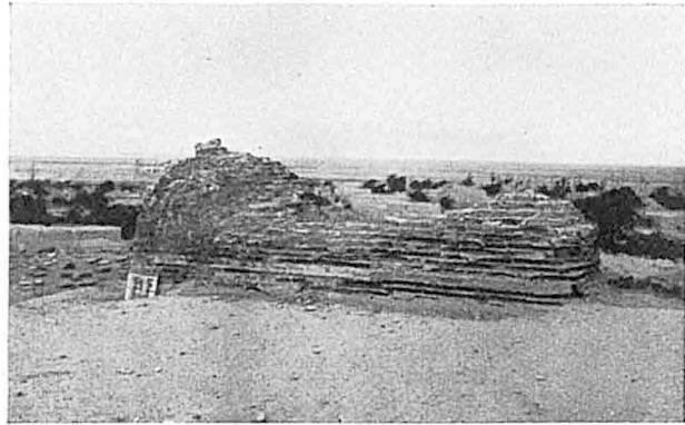
Fig. 7. — Ruine de la voûte de l'iwan.
