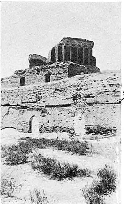
Fig. 8. — Paroi est : en s, saignée ayant reçu le voûte ajoutée.
