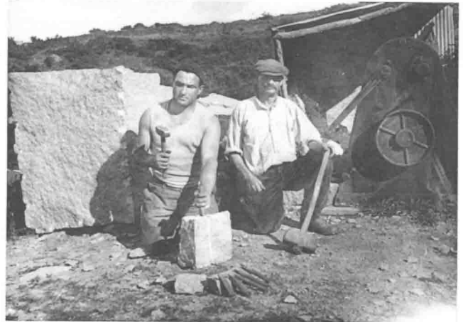
Fig. 5. — Dièlette (Manche). Extraction moderne du granit dans une petite carrière; bloc à rainures et entailles, outils employés (M. Pillet, août 1933).
