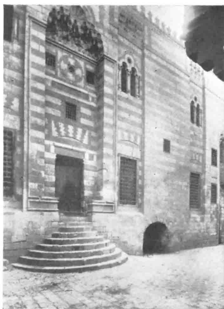
c. — Portail de la mosquée de l'Émir Misqâl.
