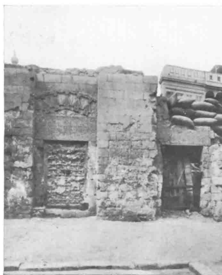
c. — Vestiges de la mosquée de Beibars (chârî' an-Nahassin).
