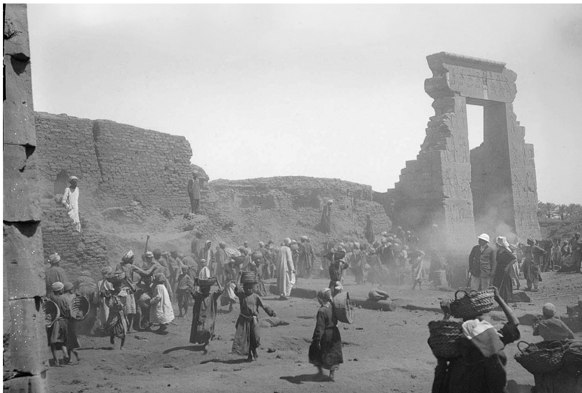
Fig. 5. Vue du site en cours de dégagement prise en 1921 depuis l'angle sud-est du mammisi romain. Fonds Maurice Pillot, archives de la Maison de l'Orient et de la Méditerranée, inv. Bo61_03.
