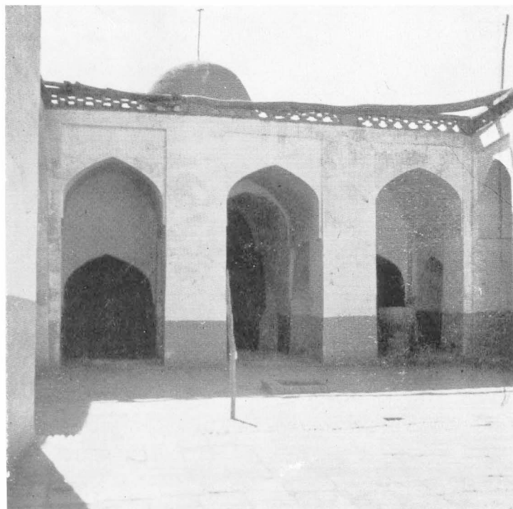
Façade Sud de la cour. Les baies de la mosquée primitive sont visibles au fond des arcades latérales.
