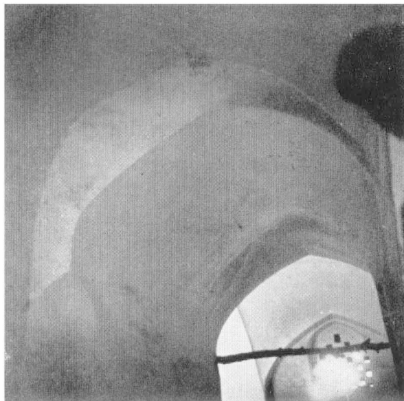
A. — Voûte refaite à l'époque seldjocide, à la base du minaret.
