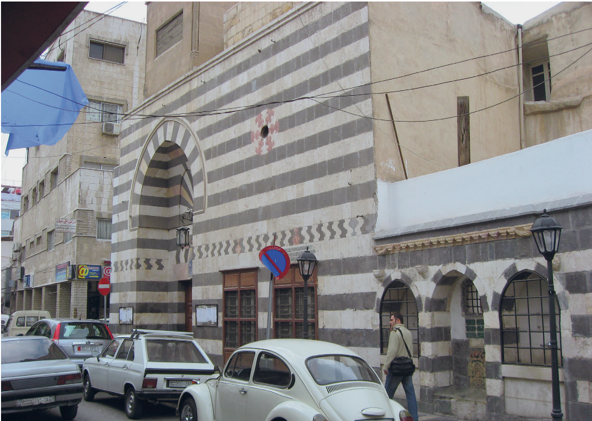
Fig. 2. Façade de la mosquée de Barsbāy (Ġāmi' al-Ward). Cliché: Élodie Vigouroux, 2010.
