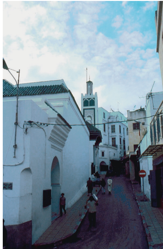
Fig. 4. Vue de la Rue de la Marine , partie de l'ancienne Rua Direita portugaise.
