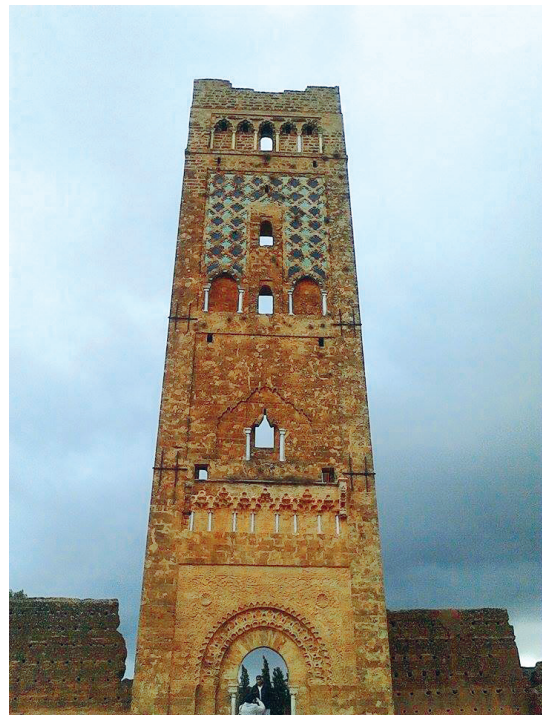
Fig. 3. Minaret de la grande mosquée de Mansoura.
