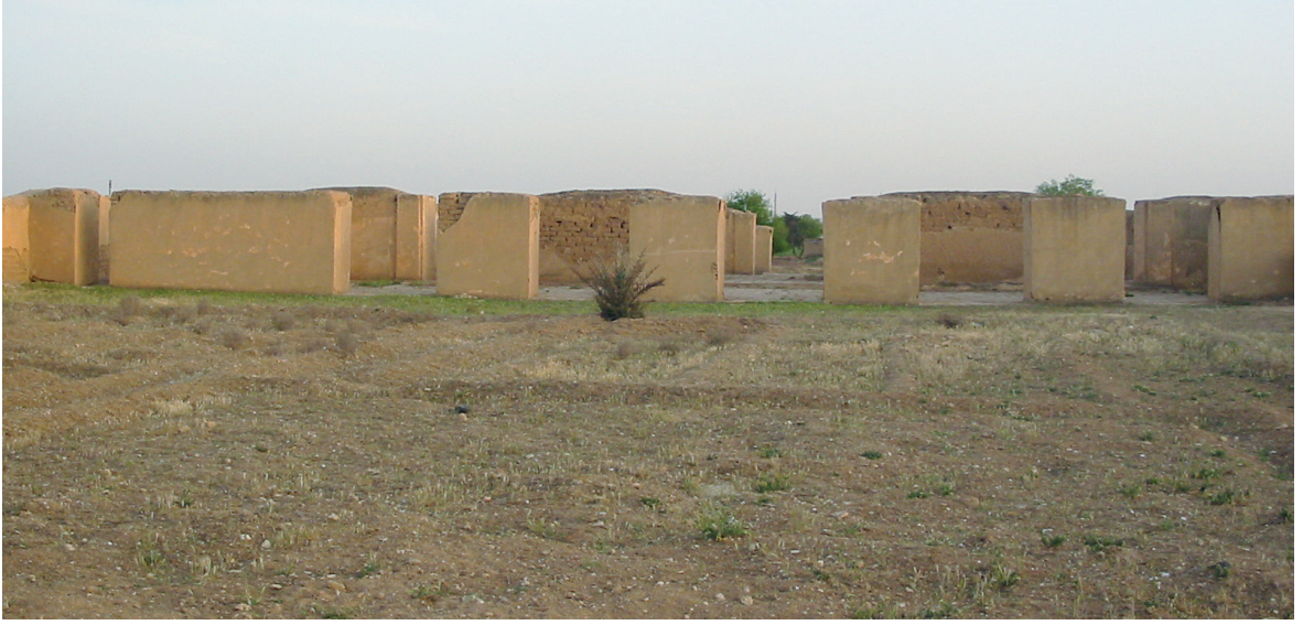
صورة ٢٤. القصر الشرقي: قسم الاستقبال. تصوير الباحثة، ٢٠٠٥.
