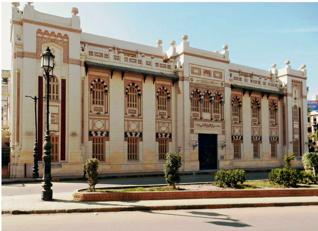
Fig. 13. Hôtel de ville, Damanhür, 1930-1931, E. Verrucci, architecte (photo E. Godoli, février 2015).
