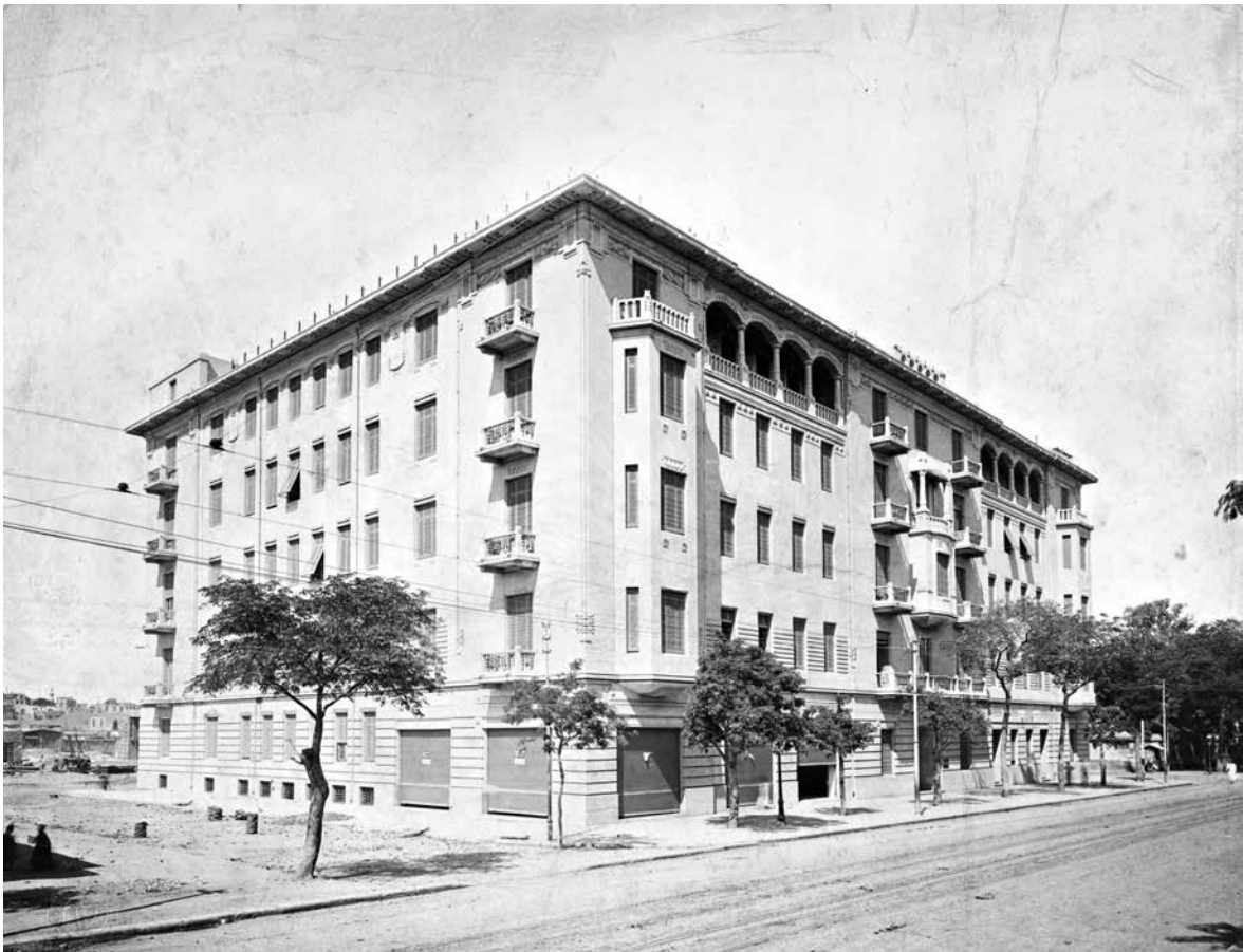
Fig. 14. P. Dittrich, photographe, Immeuble O, Immeuble de rapport pour la Société Belge-Égyptienne de l'Ezbékieh, Le Caire (Égypte), 1905 (Paris, SIAF/Centre d'archives d'architecture du xx e siècle, Fonds Bétons armés Hennebique 076 IFA, objet BAH-25-1905-08493).
