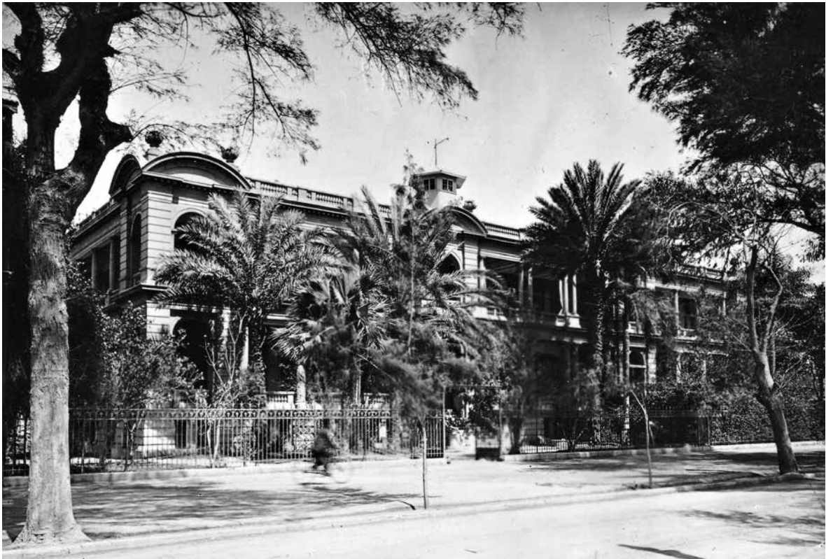
Fig. 8. Bureaux administratifs, Port-Tawfiq, 1892, Charles Marette architecte. Fonds CUCMS, Paris.
