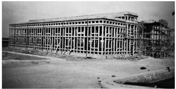
Fig. 12. Ateliers avec structure béton Hennebique, Port-Saïd, v. 19xx(?). ANMT, fonds CUCMS.
