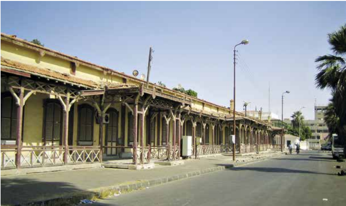
Fig. 9. Logements en barreau, Ismaïlia, v. 1890. © Claudine Piaton, 2009.
