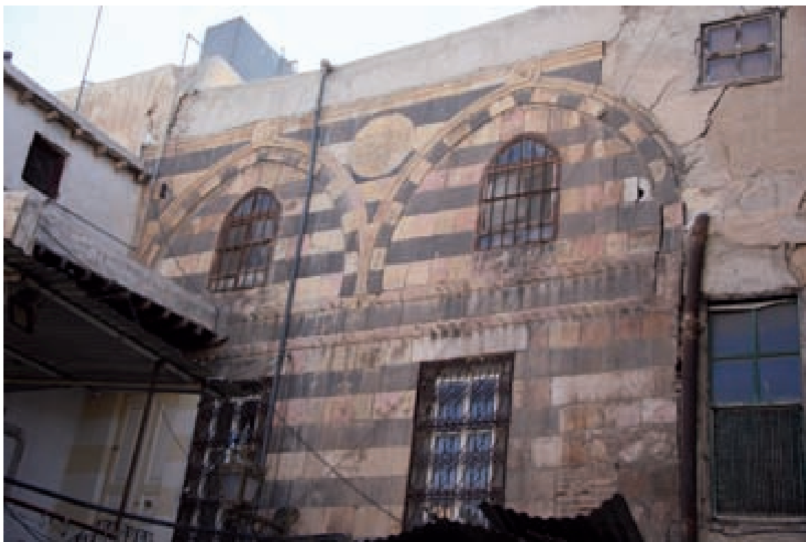
Fig. 4. Façade nord du Bayt 'Aglānī.
