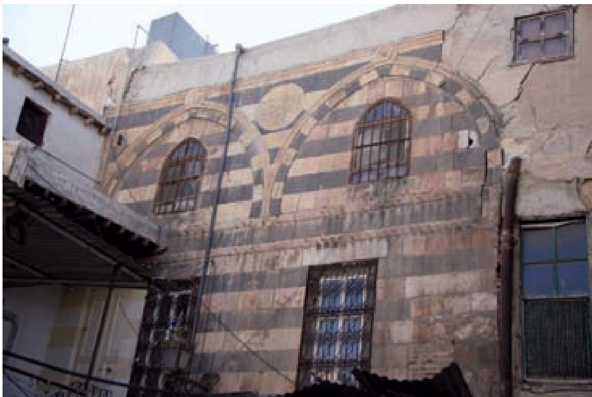
Fig. 4. Façade nord du Bayt 'Aglānī.
