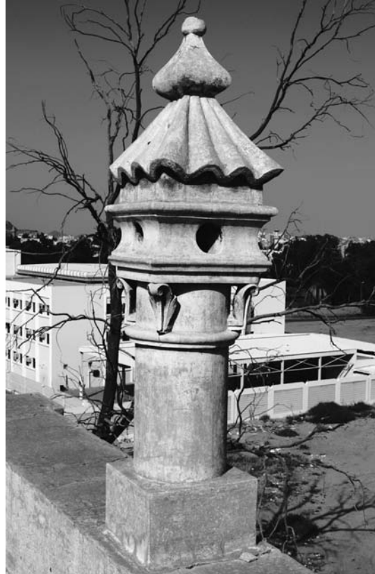
لوحة (٧). بيت الكاتب: الموقد، تفاصيل للمدخنة التي تعلو السطح العلوي.
