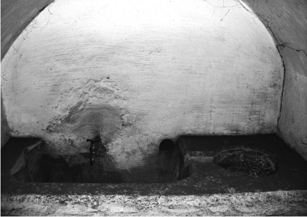
لوحة (١٥). بيت الكعكي: الطابق الأرضي، الحمام الجنوبي، الحجرة الساخنة، تفاصيل لخوضي المياه الباردة والساخنة.
