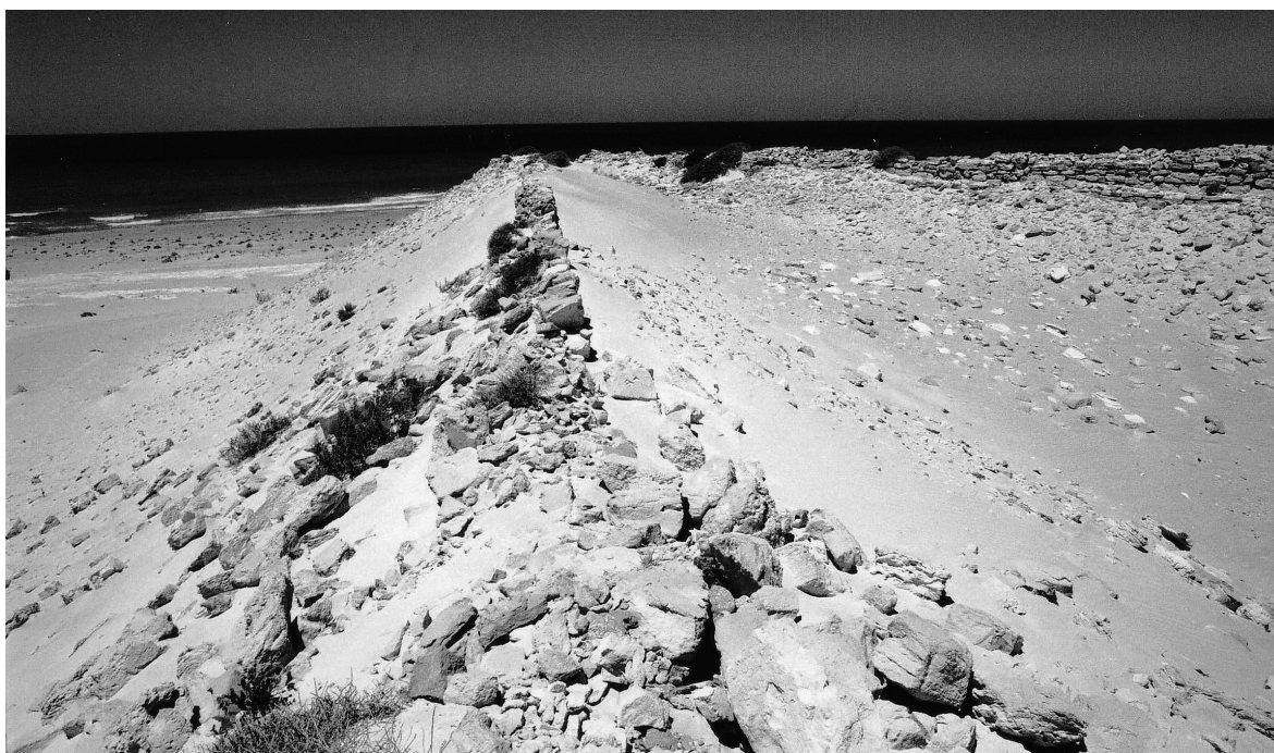
Fig. 12. Al 'Uqaylah, le fort, vue prise du sud-ouest.
