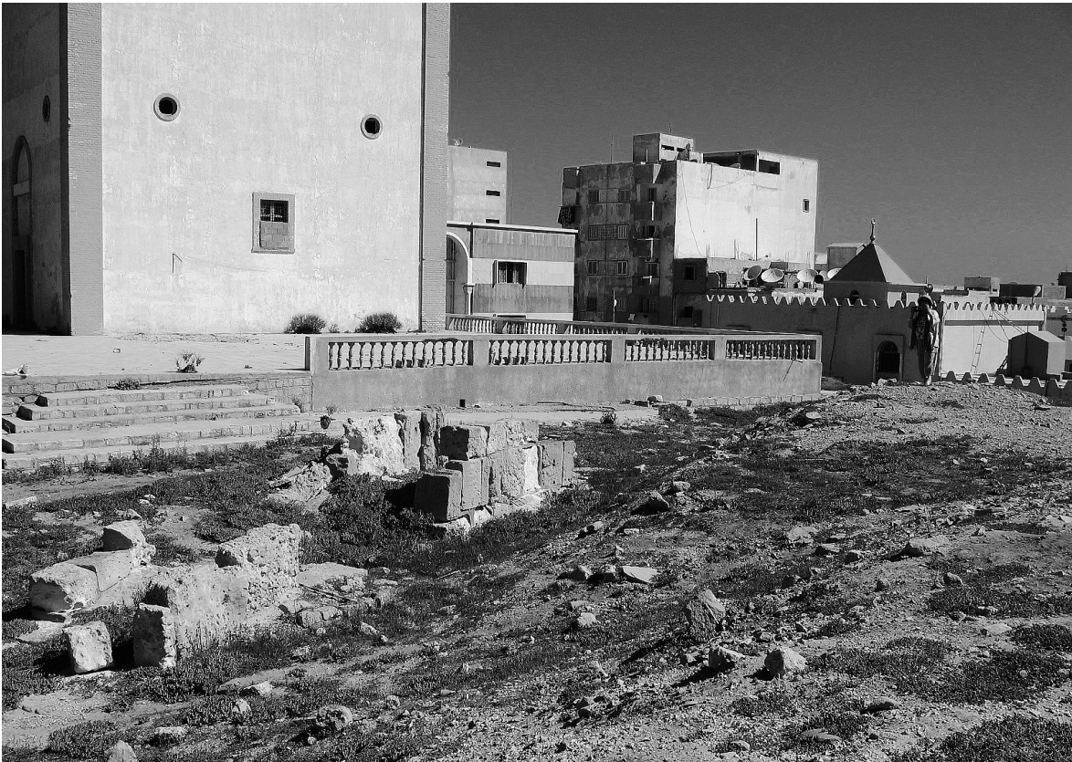
Fig. 19. Benghazi, Sidi Khrebish, mur byzantin et tour arabe (échelle photographique) au pied du phare italien.
