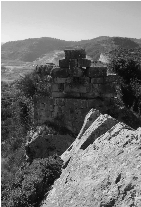
Fig. 17. Soubassements maçonnés et rupestres de la passerelle reliant les forteresses d’al-Šuġr et de Bakās à l’époque médiévale.
