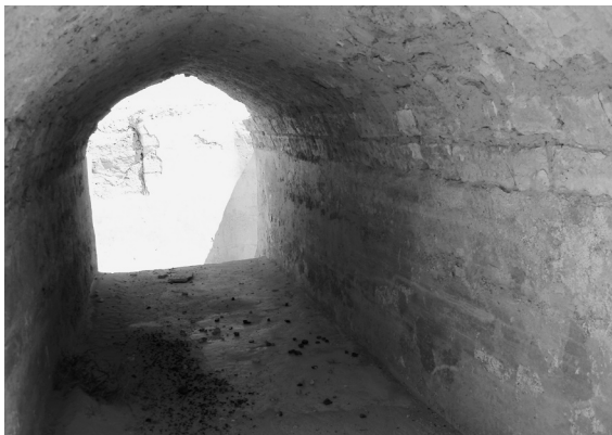
لوحة ٢٢. القناة المقبية المؤدية لمصفاة البركة الأولى الجنوبية بأبيار العلائى بعد اكتشافها.
