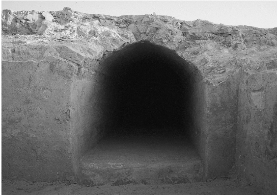
لوحة ٢٠. القناة المقبية المؤدية لمصفاة البركة الأولى الجنوبية بأبيار العلائى أثناء اكتشافها.
