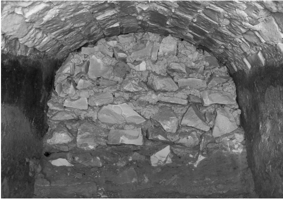
لوحة ٣٦. فتحة القناة المقيبة المؤدية لمصفاة البركة الثانية الشمالية من الناحية الجنوبية بعد سدها في عصر تالى.
