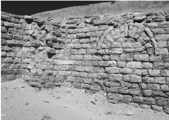
لوحة ٣٢. مصفاة البركة الثانية الشمالية وفتحة المفيض المعقودة بعد إغلاقها من الناحية الجنوبية الشرقية.
