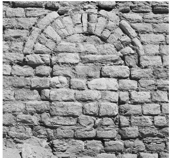
لوحة ٣٣. فتحة المفيض المعقودة من داخل مصفاة البركة الثانية الشمالية بعد سدها فى عصر تالى لتستخدم كبركة صغيرة للمياه.
