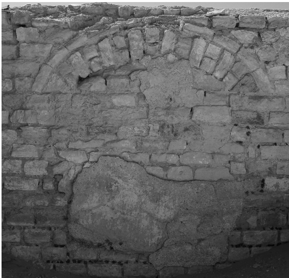
لوحة ٣٤. فتحة القناة المقيية من داخل مصفاة البركة الثانية الشمالية، وقد تم سدها فى عصر تالى لتستخدم كبركة صغيرة للمياه.
