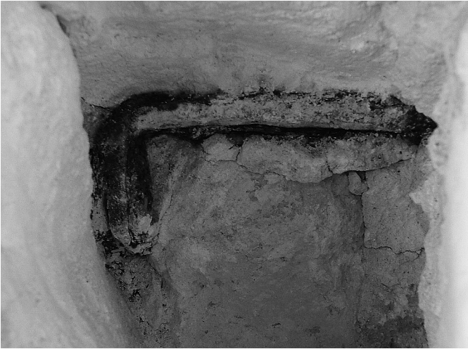
Fig. 18. Détail d'une agrafe en fer.
