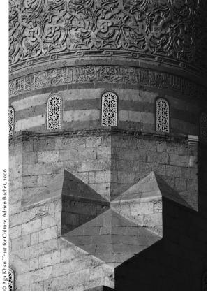
Fig. 9. Détail de la zone de transition, des pyramidions et des baies hautes.
