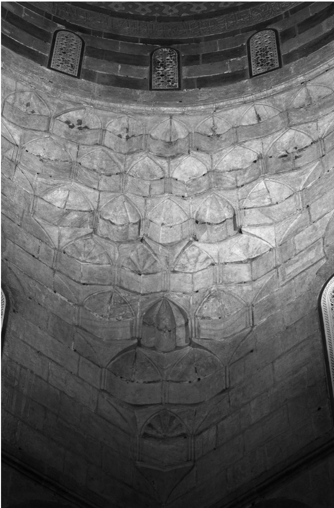
Fig. 14. Détail de la zone de transition et des muqarnas .
