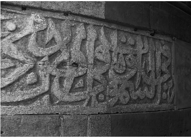
Fig. 20. Détail des cales en bois.
