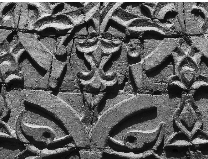
Fig. 22. Détail de la relation entre construction et décor, avant restauration.
