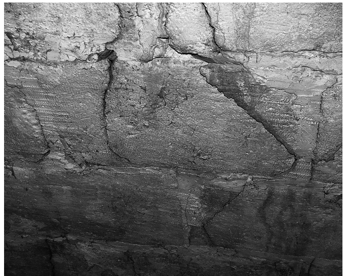
Fig. 27. Traces d'outils de ravalement intérieur, avec traces de gradine à dents.
