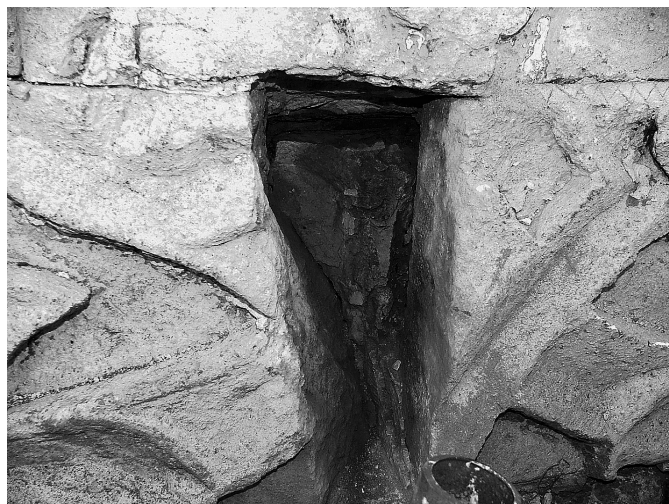
Fig. 17. Détail d'une agrafe en fer.
