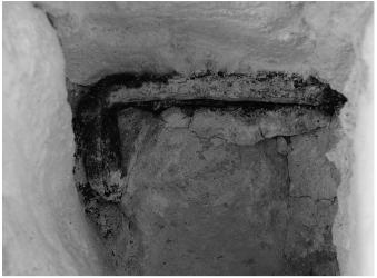
Fig. 18. Détail d'une agrafe en fer.
