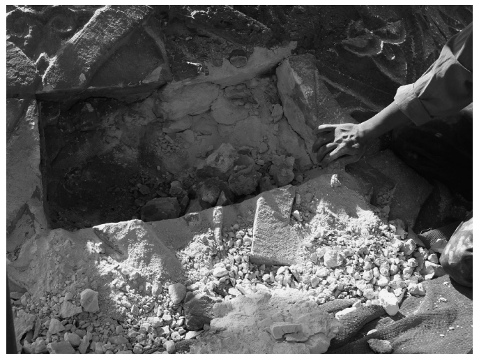
Fig. 23. Détail de dépose d'une pierre du cône sommital.
