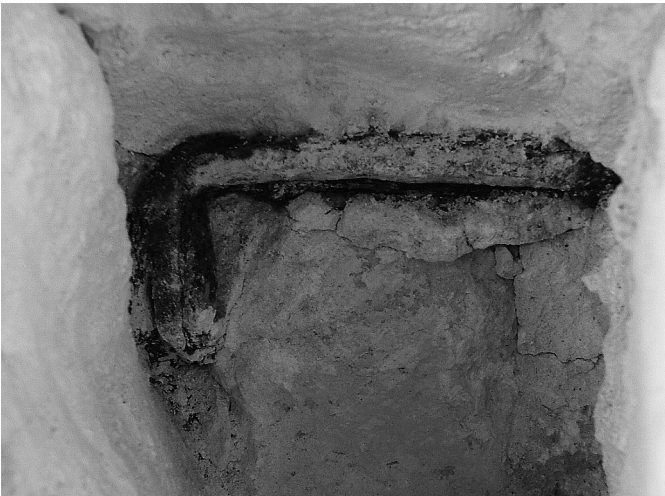
Fig. 18. Détail d'une agrafe en fer.
