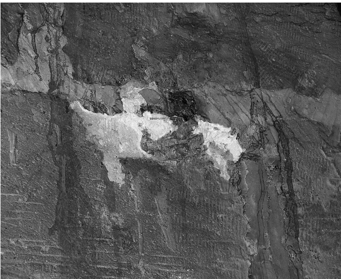
Fig. 26. Traces d'outils de ravalement intérieur, avec traces de taillant droit sur les joints.
