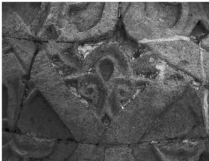
Fig. 25. Détail des vestiges de badigeon de chaux sur l'extrados de la coupole.
