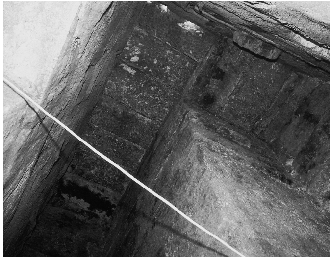
Fig. 48. Couloir 7-8, vue d'ensemble du couvrement.
