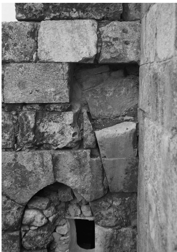
Fig. 47. Pièce 26, détail de l'angle sud-est.
