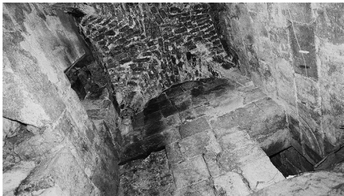
Fig. 36. Pièce 4, vue générale des parties hautes.
