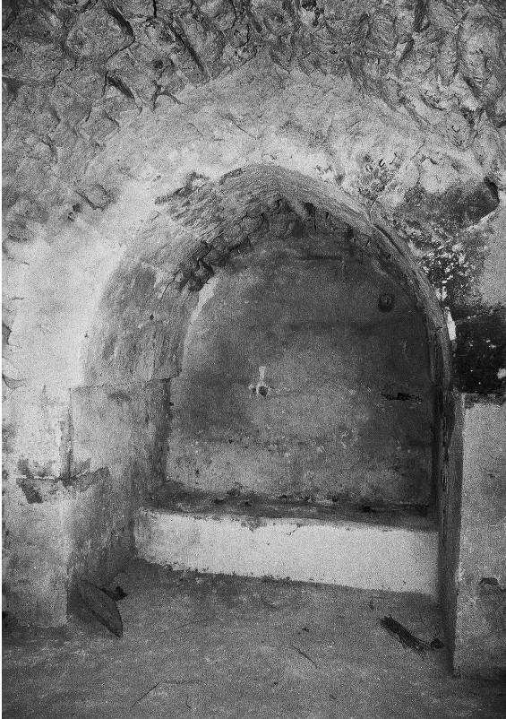
Fig. 50. Pièce 2, vue du haut du renforcement ouest (le sol actuel coupe en deux le volume primitif).
