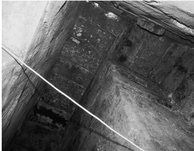
Fig. 48. Couloir 7-8, vue d'ensemble du couvrement.
