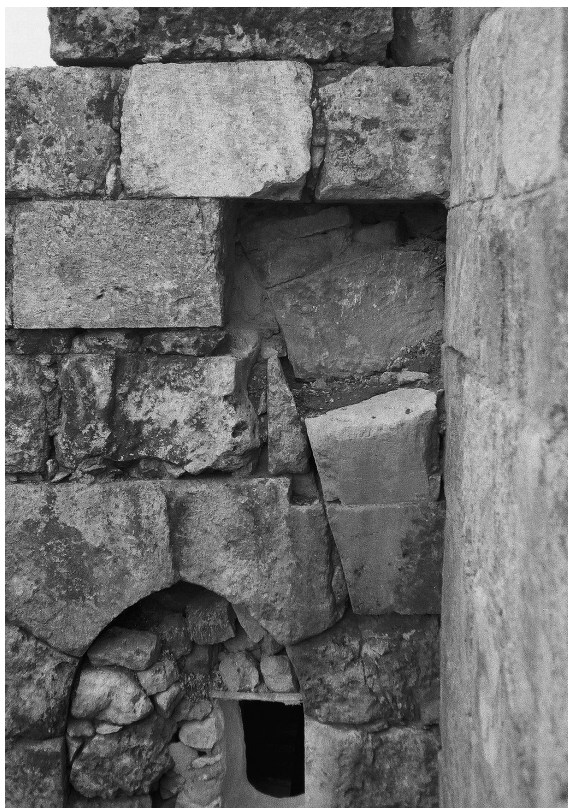
Fig. 47. Pièce 26, détail de l'angle sud-est.
