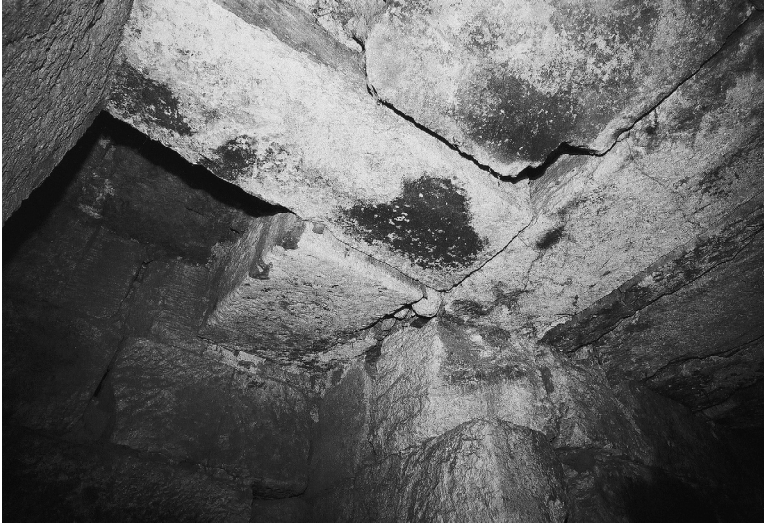
Fig. 57. Voûtement à la rencontre des couloirs 18 et 19.
