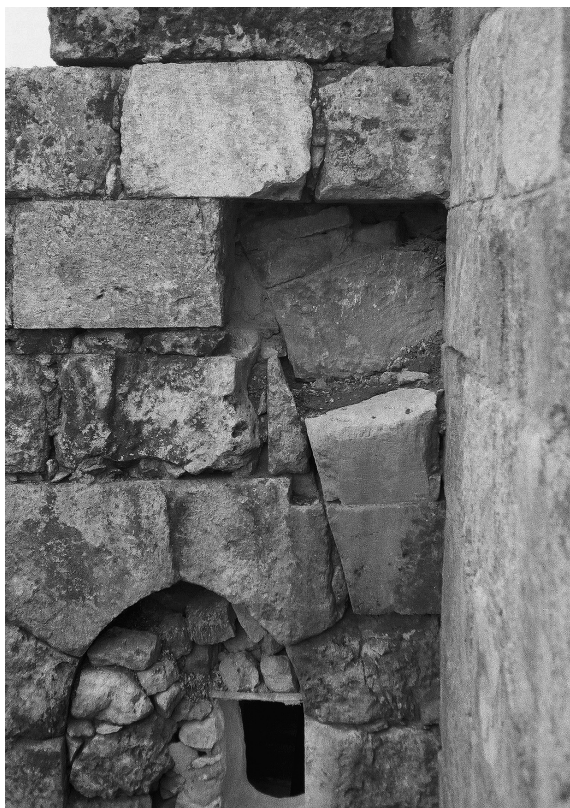
Fig. 47. Pièce 26, détail de l'angle sud-est.
