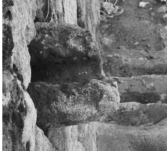
Fig. 60. Terrasse nord-est, pierre débordante sur la face nord.
