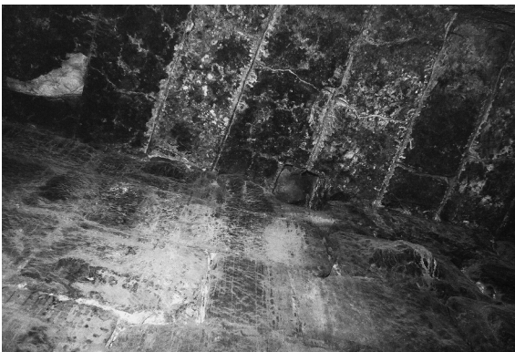
Fig. 52. Couloir 6, détail de la partie haute de la paroi sud et du plafond.
