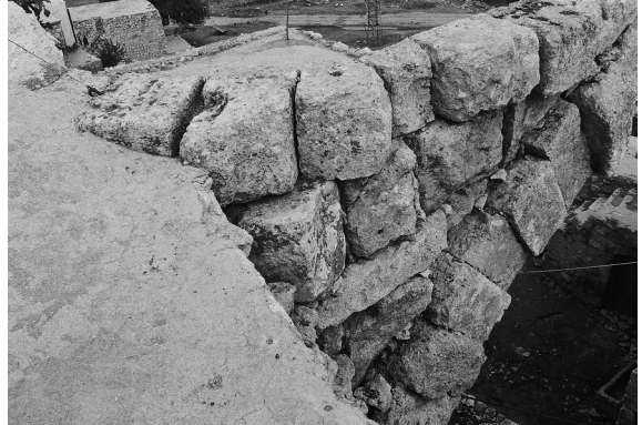
Fig. 40. Espace central, revers de l'angle nord-ouest.
