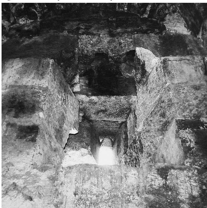
Fig. 66. Archère du mur est de la pièce 4.
