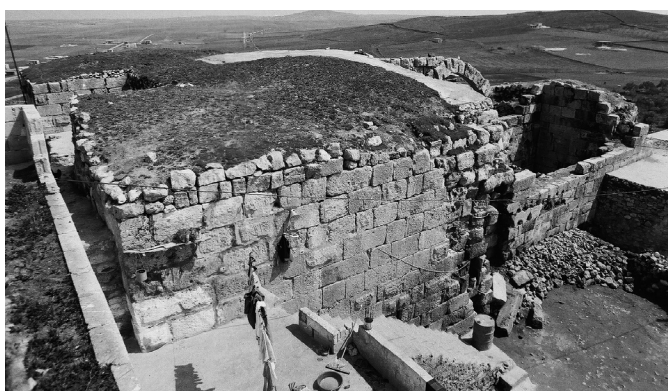
Fig. 33. Angle nord-ouest de la construction.
