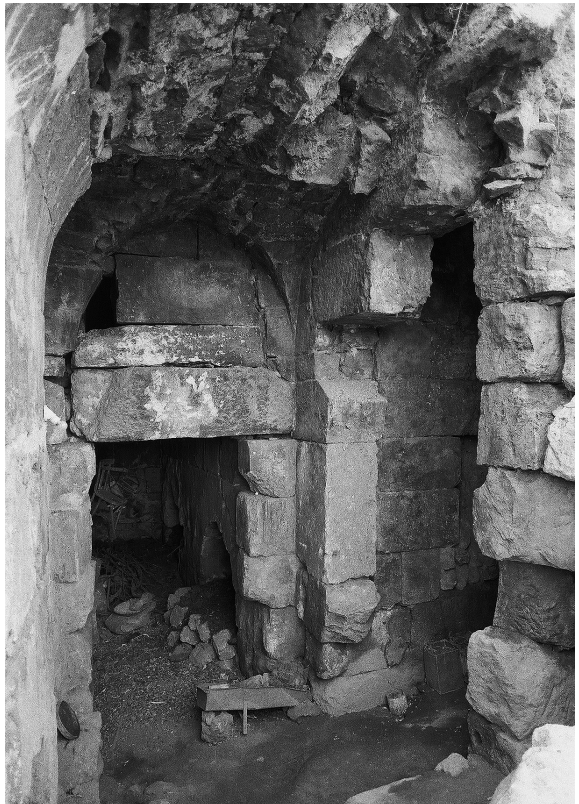
Fig. 42. Espace 22, vue depuis le sud montrant l'extrémité des couloirs 13 (à gauche) et 23 (à droite).
