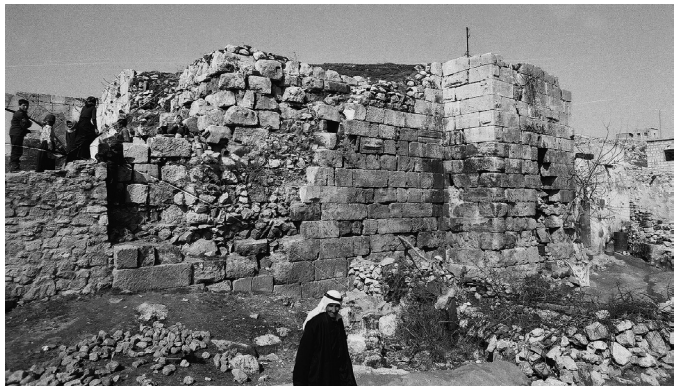
Fig. 35. Face est de la construction, partie septentrionale.
