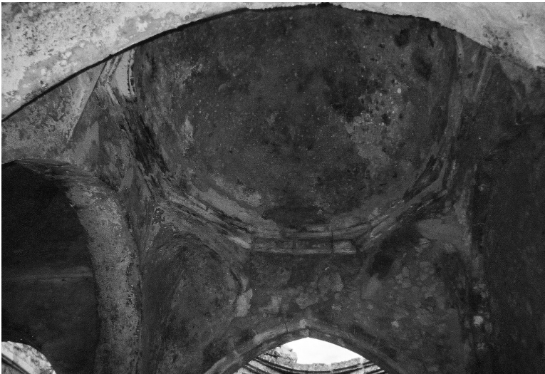
Fig. 12 a. Les coupoles de la grande mosquée de Kilwa.
