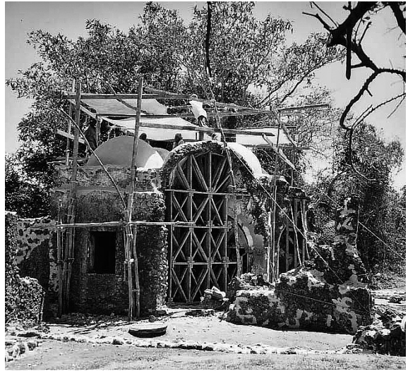
Fig. 22. La petite mosquée, en cours de restauration, Kilwa.
