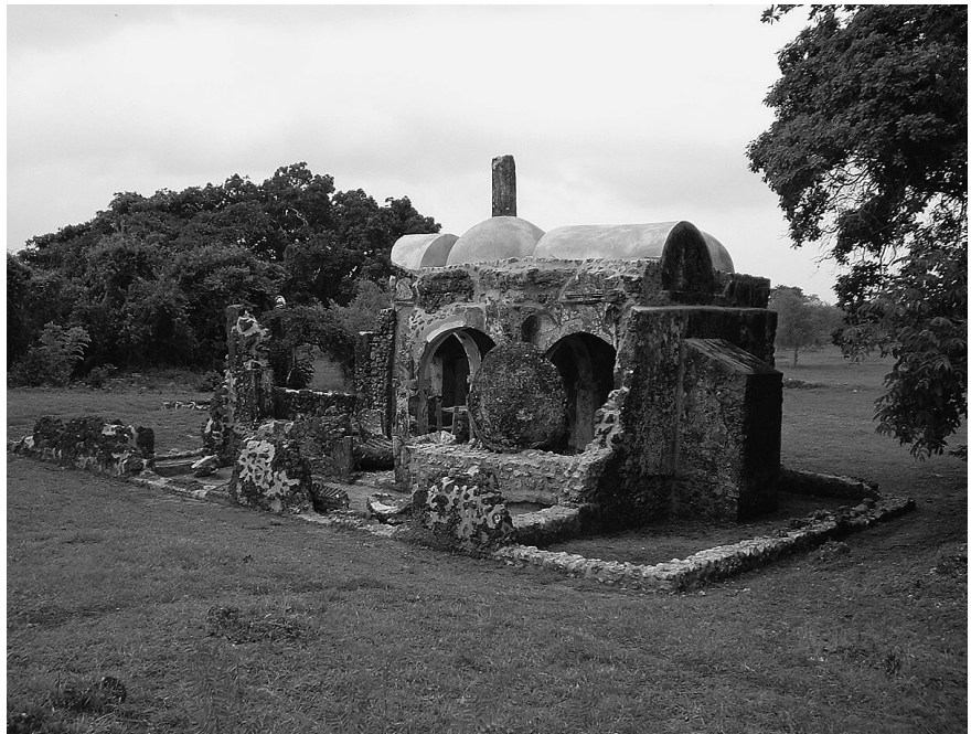
Fig. 23. La petite mosquée restaurée, Kilwa.
