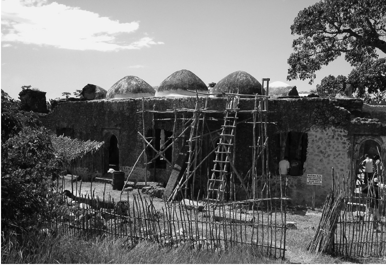
Fig. 11. La grande mosquée de Kilwa, pendant les travaux de restauration.
