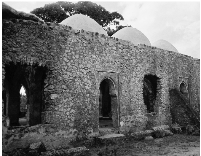
Fig. 13. La grande mosquée de Kilwa, vue de l'ouest, après restauration.
