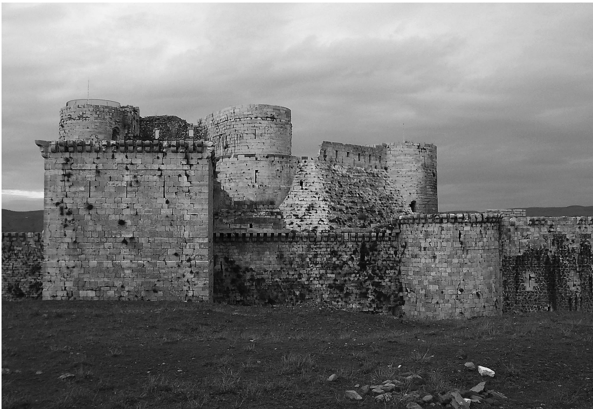
Fig. 4. Détail du front sud (à gauche : tour saillante carrée ; à droite : tour-porte semi-circulaire ; en arrière-plan : le donjon des Hospitaliers).
