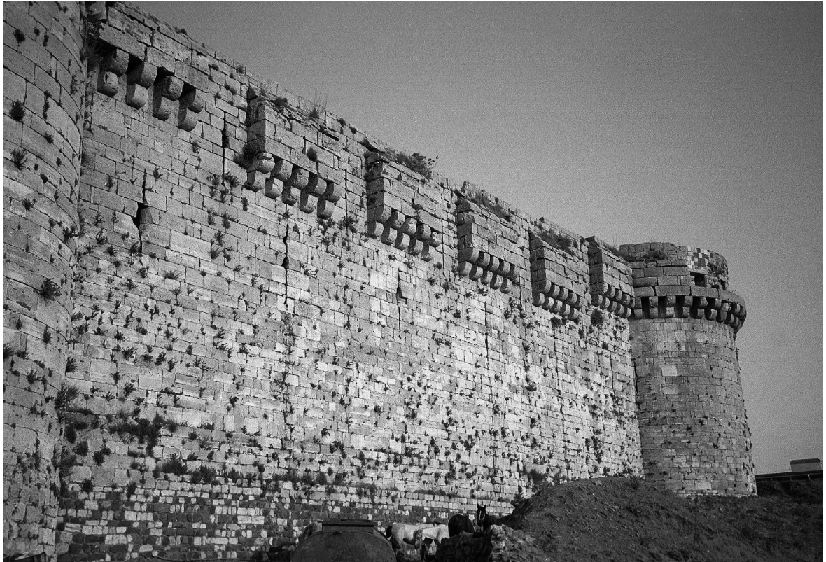
Fig. 9. Angle sud-ouest, façade extérieure (système de défense sommitale de la courtine avec un circuit continu à alternance de bretèches et d'archères).
