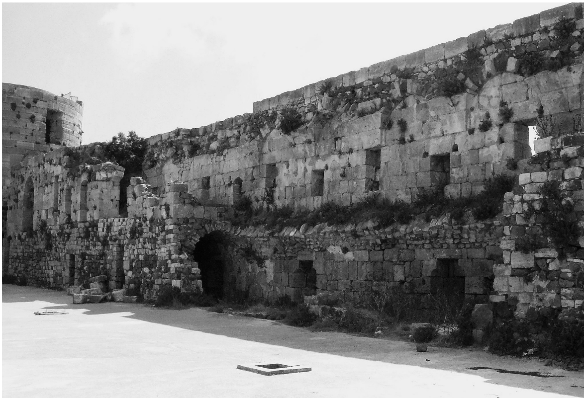
Fig. 12. Courtine orientale du chateau haut, niveau supérieur (épaissement et surélévation de la courtine croisée avec création d'une gaine à archères supportant un niveau de chemin de ronde à archères).
