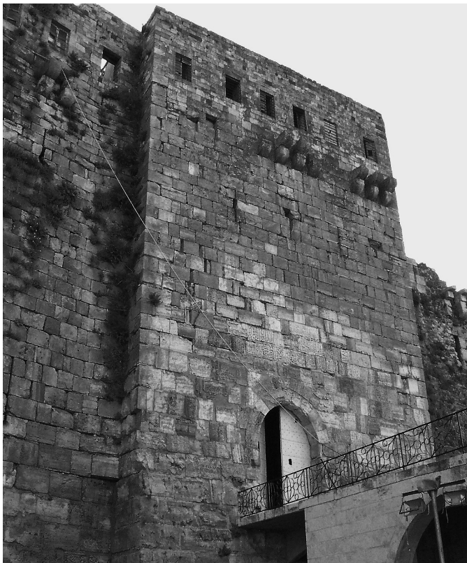
Fig. 6. Tour-porte du front est (reconstruction partielle et surélévation par Baybars).
