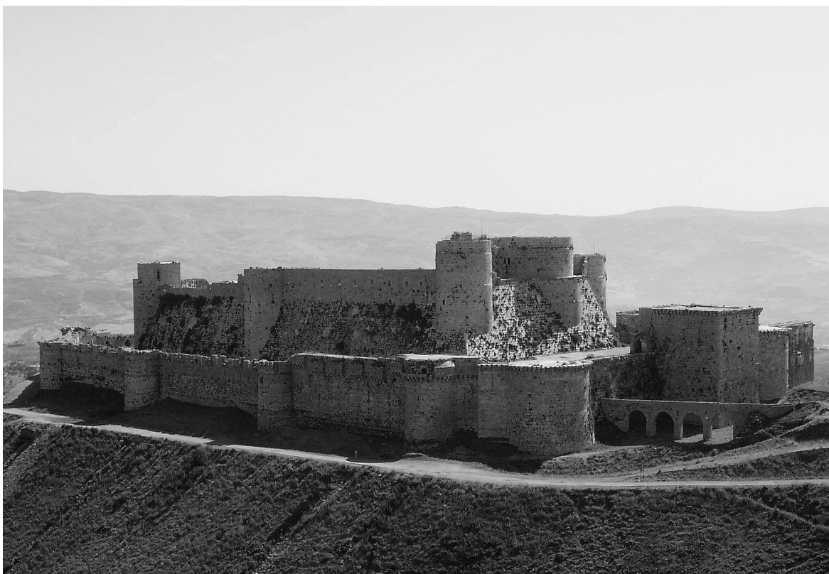
Fig. 3. Vue générale du Crac des Chevaliers (en arrière-plan : le château haut ; au premier plan à droite : le front sud).
