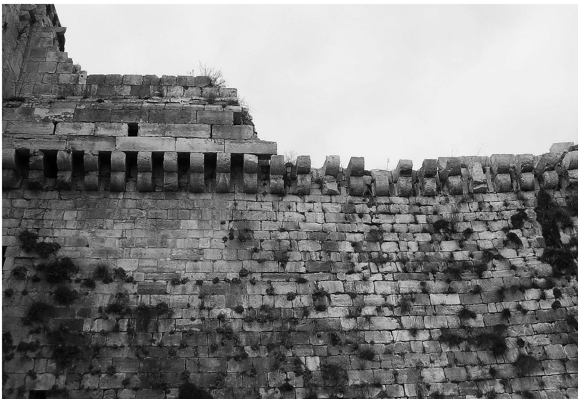
Fig. 11. Détail de la gaine à mâchicoulis du front sud (cette gaine supportait un niveau de chemin de ronde avec parapet crénelé).
