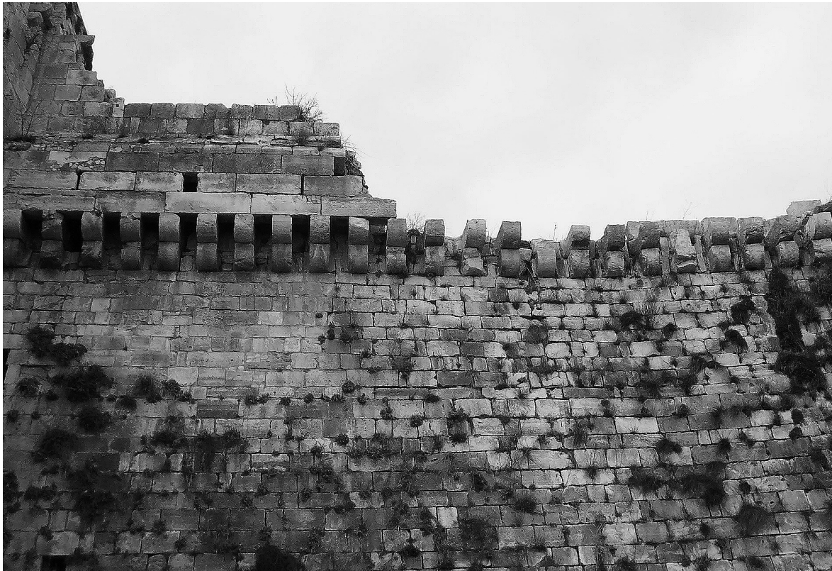
Fig. 11. Détail de la gaine à mâchicoulis du front sud (cette gaine supportait un niveau de chemin de ronde avec parapet crénelé).
