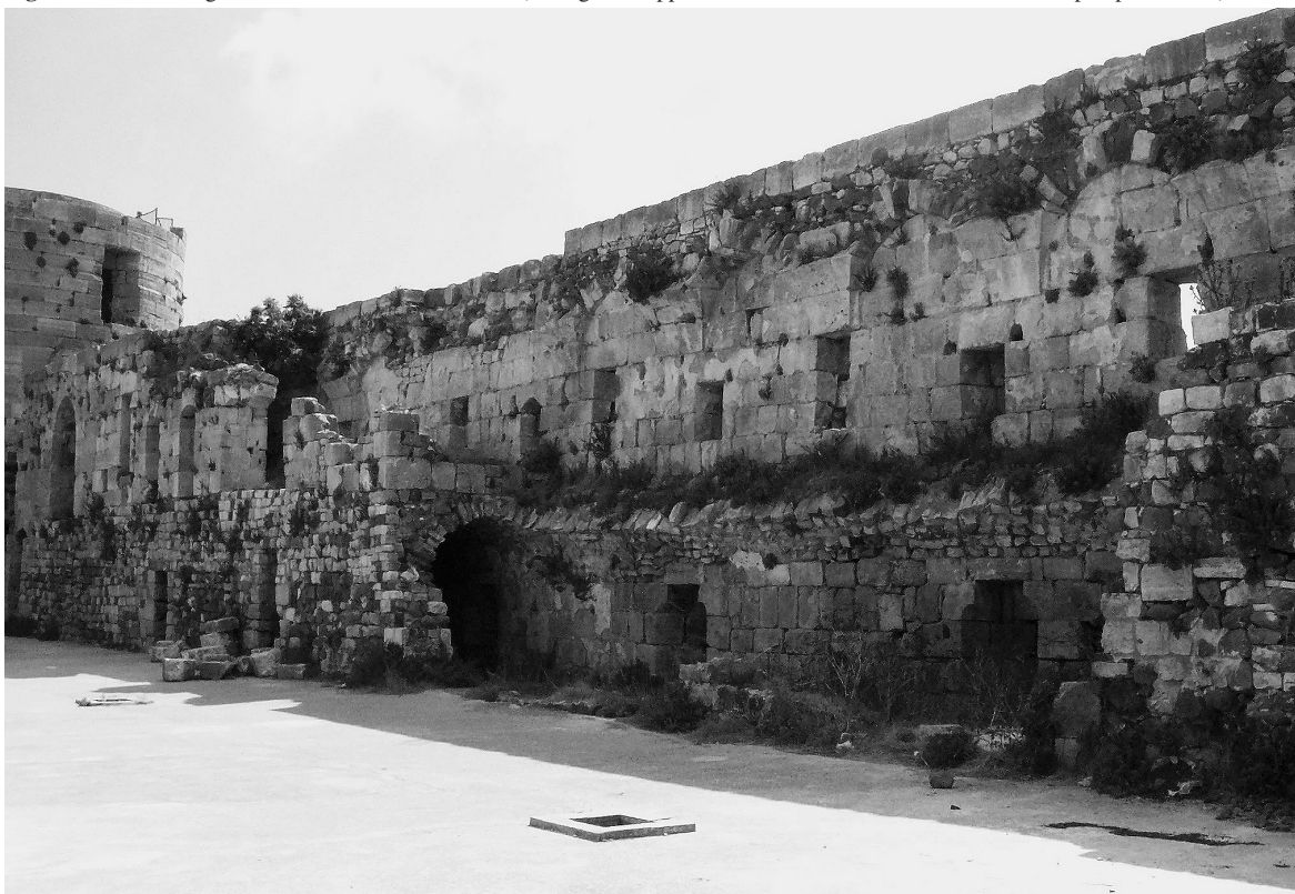
Fig. 12. Courtine orientale du chateau haut, niveau supérieur (épaississement et surélévation de la courtine croisée avec création d'une gaine à archères supportant un niveau de chemin de ronde à archères).
