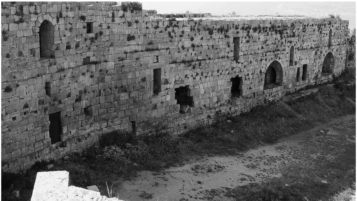
Fig. 10. Angle sud-ouest, façade intérieure (épaissement et surélévation de la courtine croisée avec aménagement d'un passage entre les niches d'archère au niveau inférieur).
