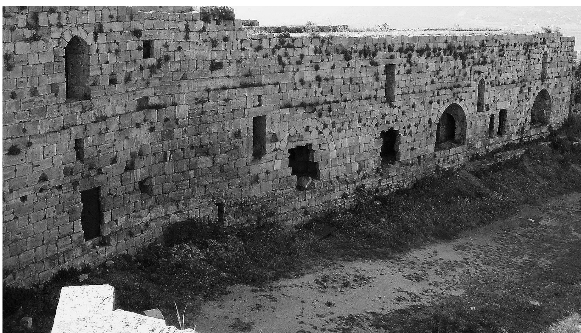
Fig. 10. Angle sud-ouest, façade intérieure (épaississement et surélévation de la courtine croisée avec aménagement d'un passage entre les niches d'archère au niveau inférieur).
