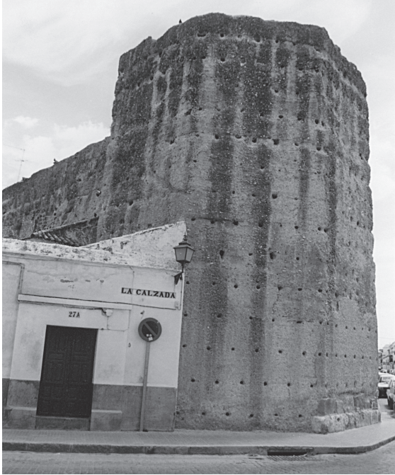
صورة ٧. استجة. برج مئمن فى إحدى زوايا سور المدينة.
