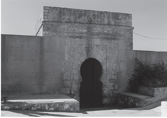
صورة ١٥. لبله. باب الماء، الواجهة الداخلية.
