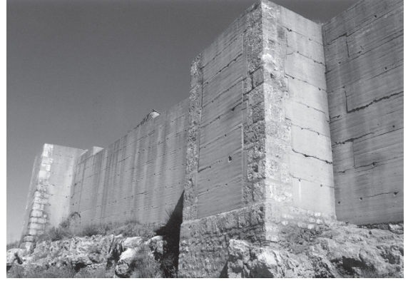
صورة ١. لبله. الواجهة الخارجية للبرج والبرجين (١٧) و(١٨).
