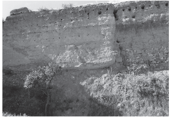
صورة ٢. لبله. تفاصيل الطابية شرق باب إشبيلية.
