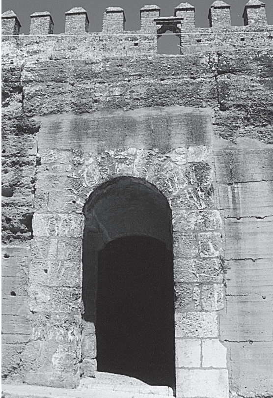
صورة ١١. لبلة. باب النجدة، الواجهة الداخلية.
