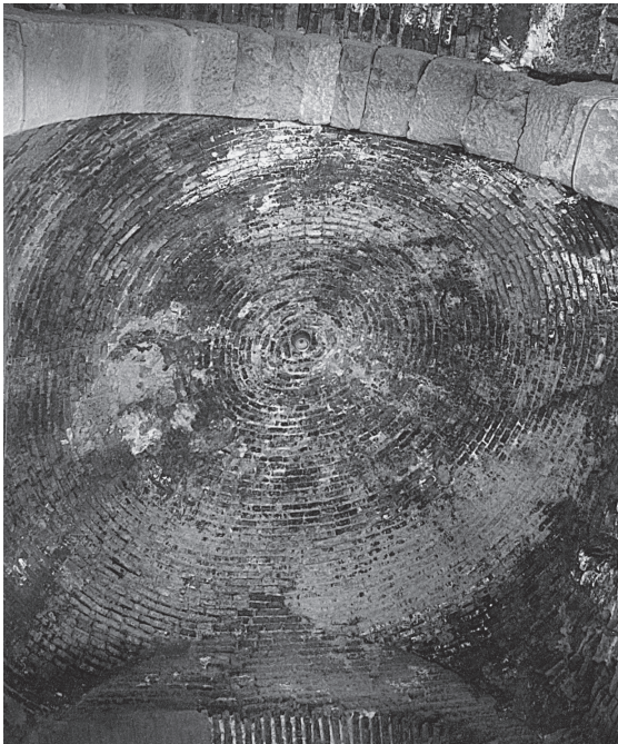
صورة ١٣. لبلة. باب إشبيلية، القبة الضحلة التي تغطي المساحة الوسطى.
