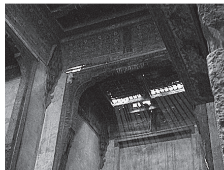
7.7. Plafond de l'iwān sud.
