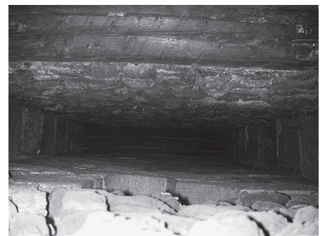
7.10. Conduit de ventilation nord.
