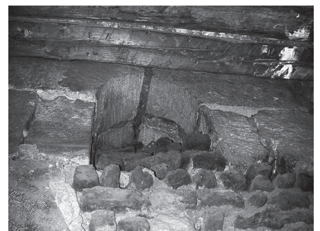
7.11. Conduit de ventilation nord.
