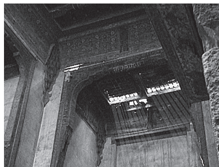
7.7. Plafond de l'iwān sud.
