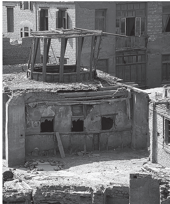
6.6. La toiture de la durqa'a .
