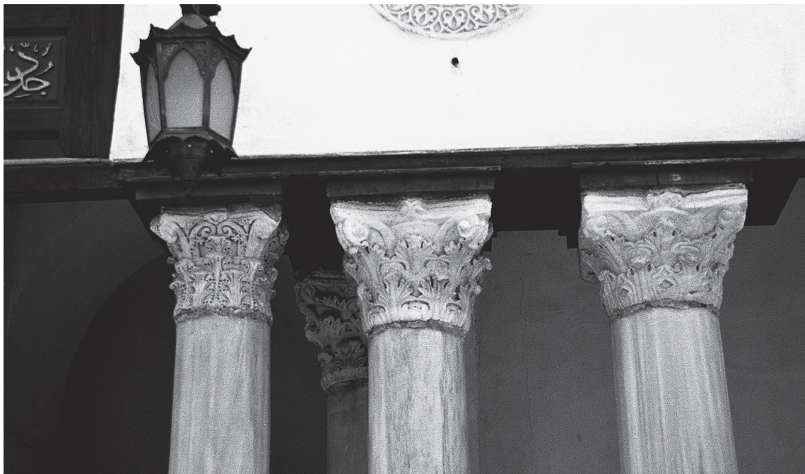
17. Chapiteaux 1a, 1b, 1c (de gauche à droite), 1d au fond.
