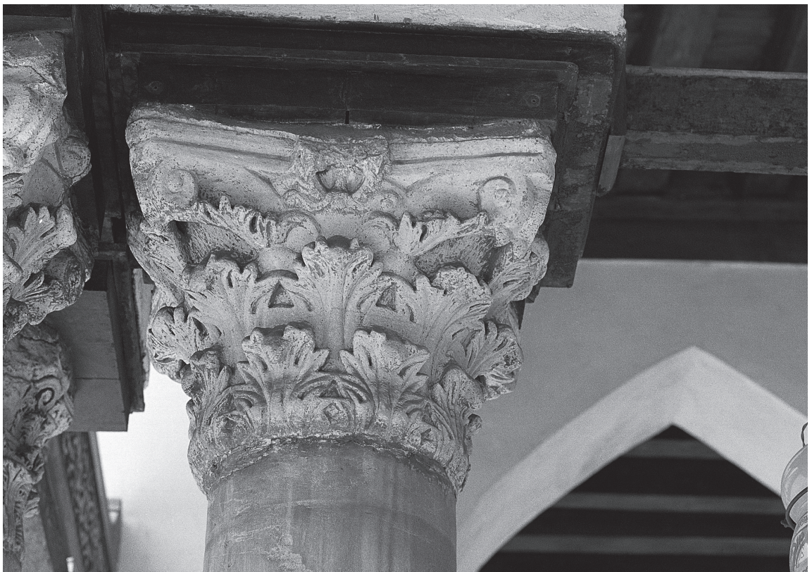
14. Chapiteau 1d, corinthien classique à deux couronnes, à la place de la fleur d'abaque une croix dans une couronne de laurier à rubans.
