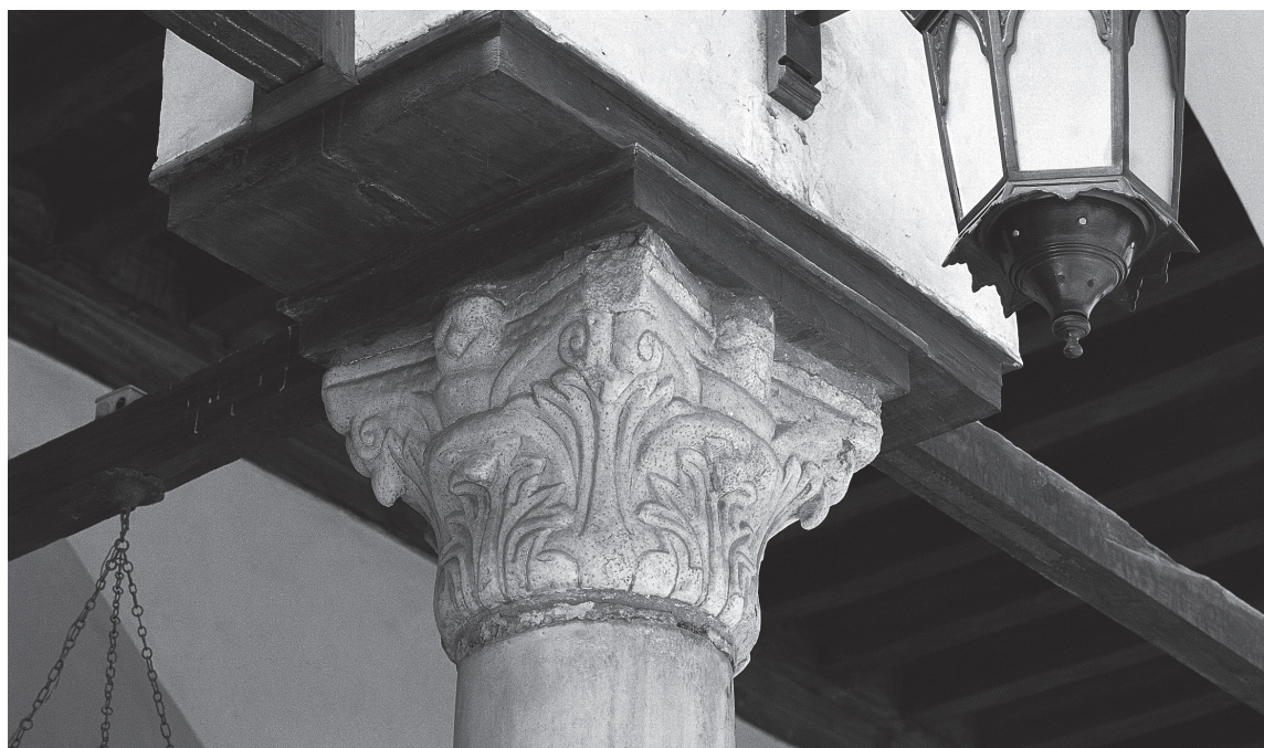
4. Type 3-B, chapiteau 34, corinthisant à deux couronnes de quatre feuilles, toutes les feuilles partent de la base du chapiteau.
