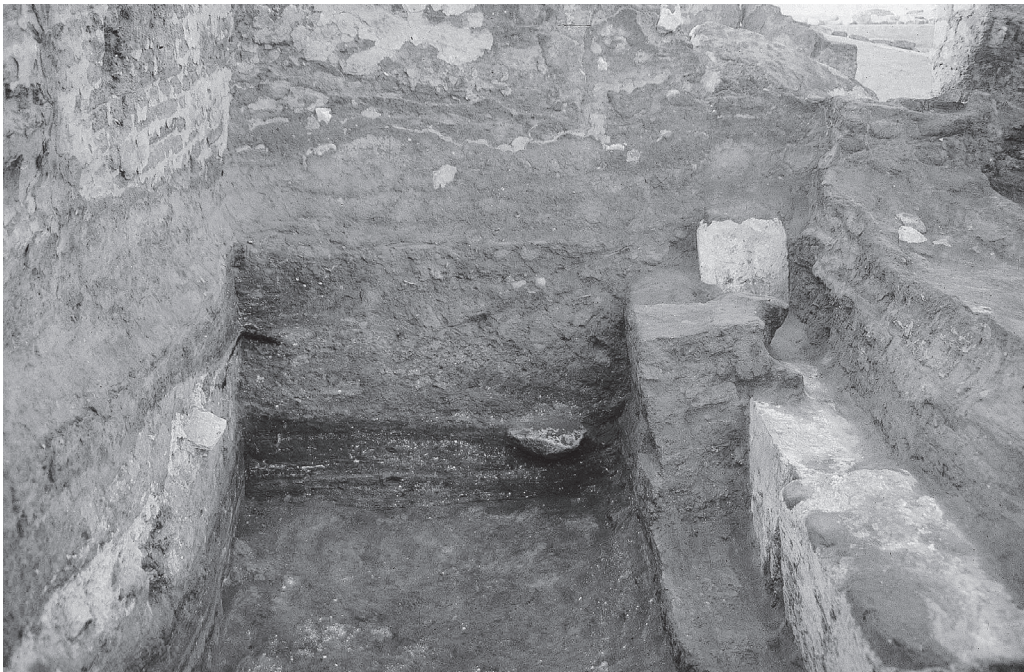
6. Mur X153, état byzantin pièce 16.
