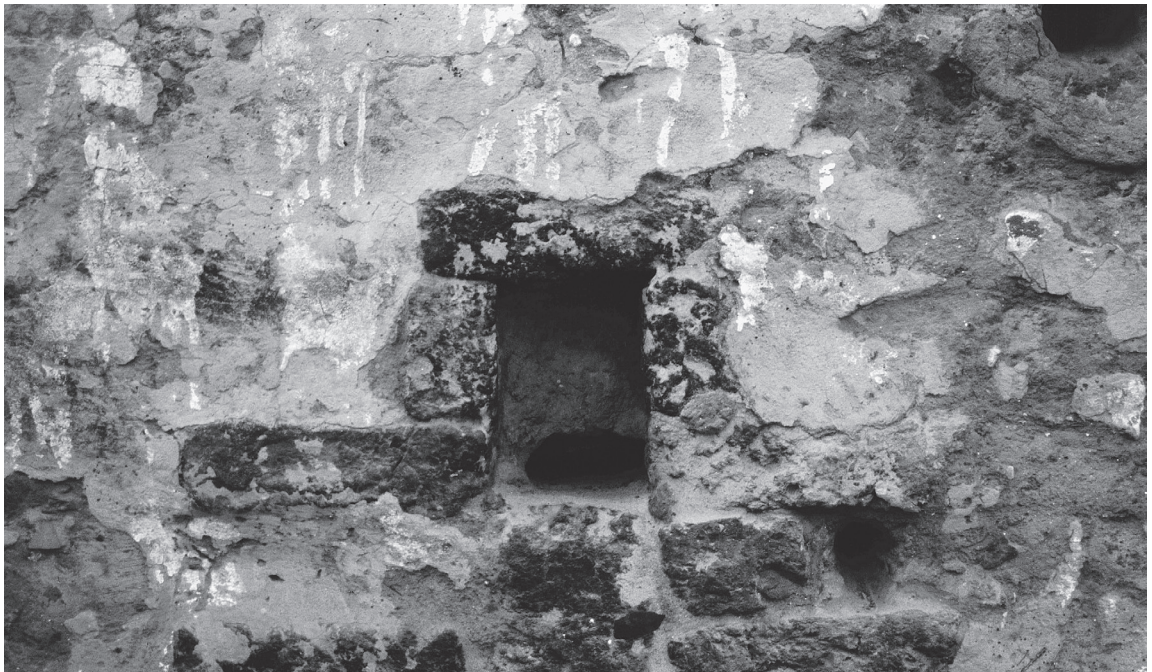
19. Détail d'une fente verticale maçonnée en briques cuites, à l'est de la niche, dans le mur X329 (état 2).
