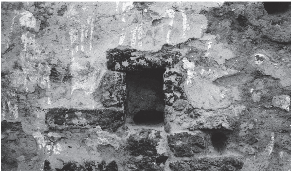
19. Détail d'une fente verticale maçonnée en briques cuites, à l'est de la niche, dans le mur X329 (état 2).
