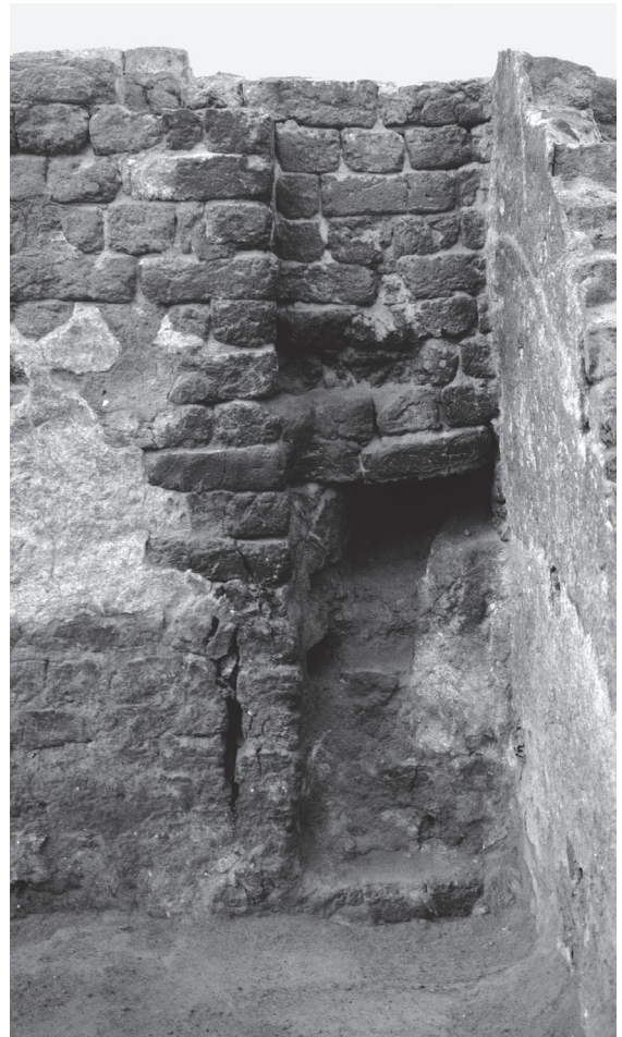
18. L'encoche à l'extrémité ouest du mur X329, pièce 2 (état 2).
