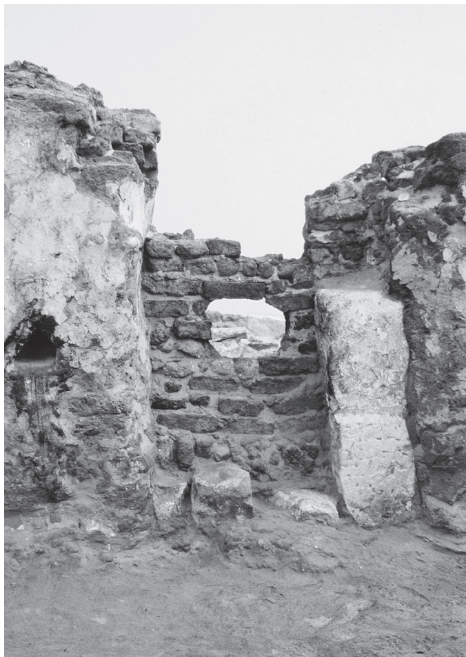
21. Porte nord de la pièce 9, bouchée à l'état 5 et orifice triangulaire dans le parement sud du mur X332 (état 2).
