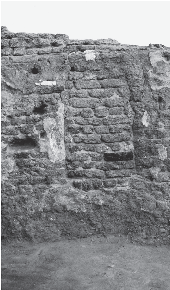
22. Pièce 2, niche ronde dans le mur X332 (état 2) bouchée à l'état 3. Une croix tracée à la peinture rouge est visible à gauche, sur l'enduit blanc.
