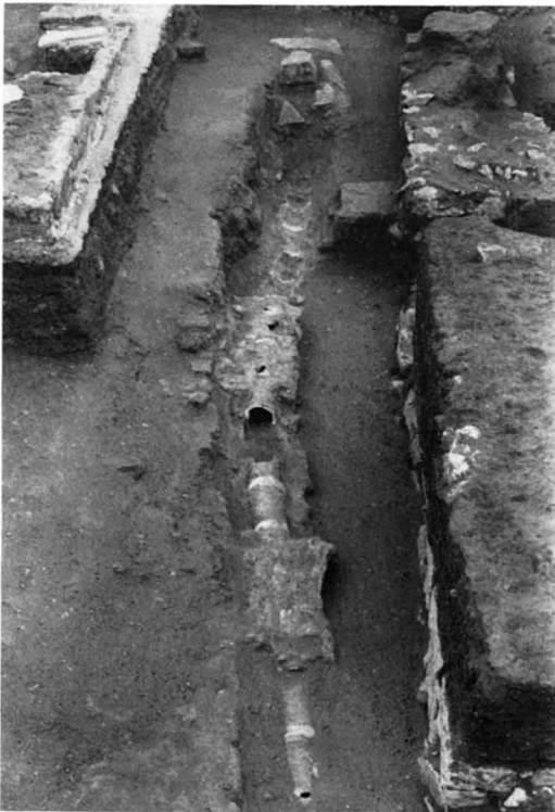
Fig. 3. Canalisations du XI e siècle dans une ruelle bordant le complexe funéraire.
