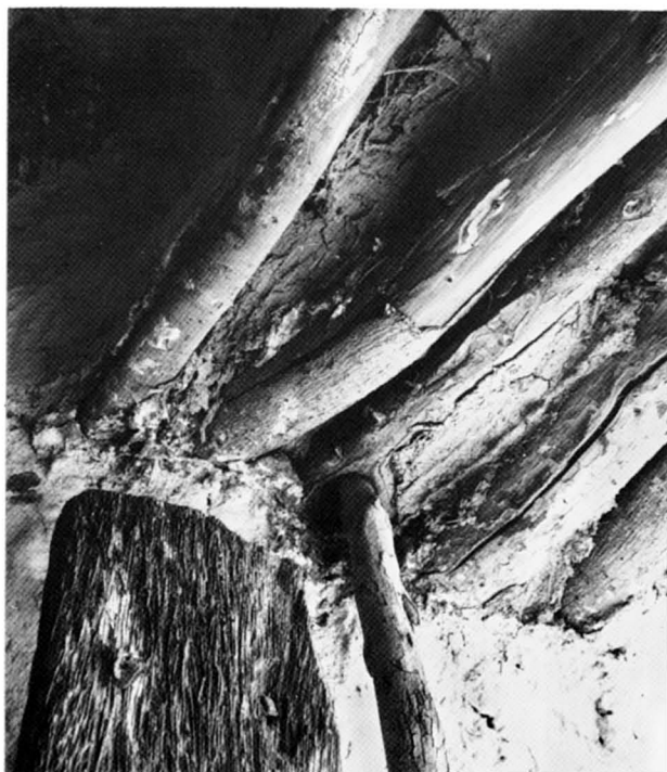
a – Fourche maintenant le pivot du vantail.
