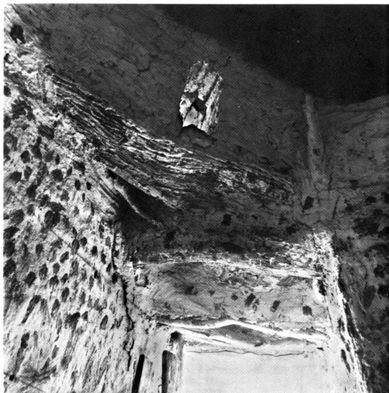
a — Branches d'acacia supportant le tambour de la coupole : angle nord-est.
