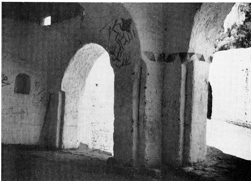
Mausolée du cheikh 'Umar : Salle (2), vues intérieures.
