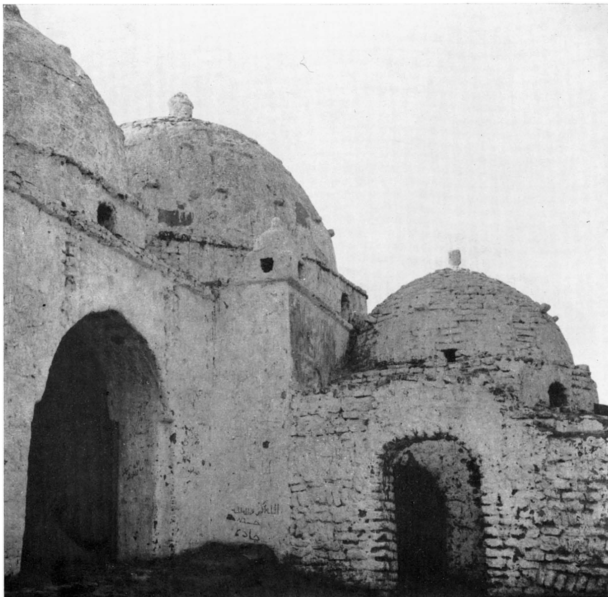
Mausolée du cheikh 'Umar : Cour (1), angle Sud-Ouest.
