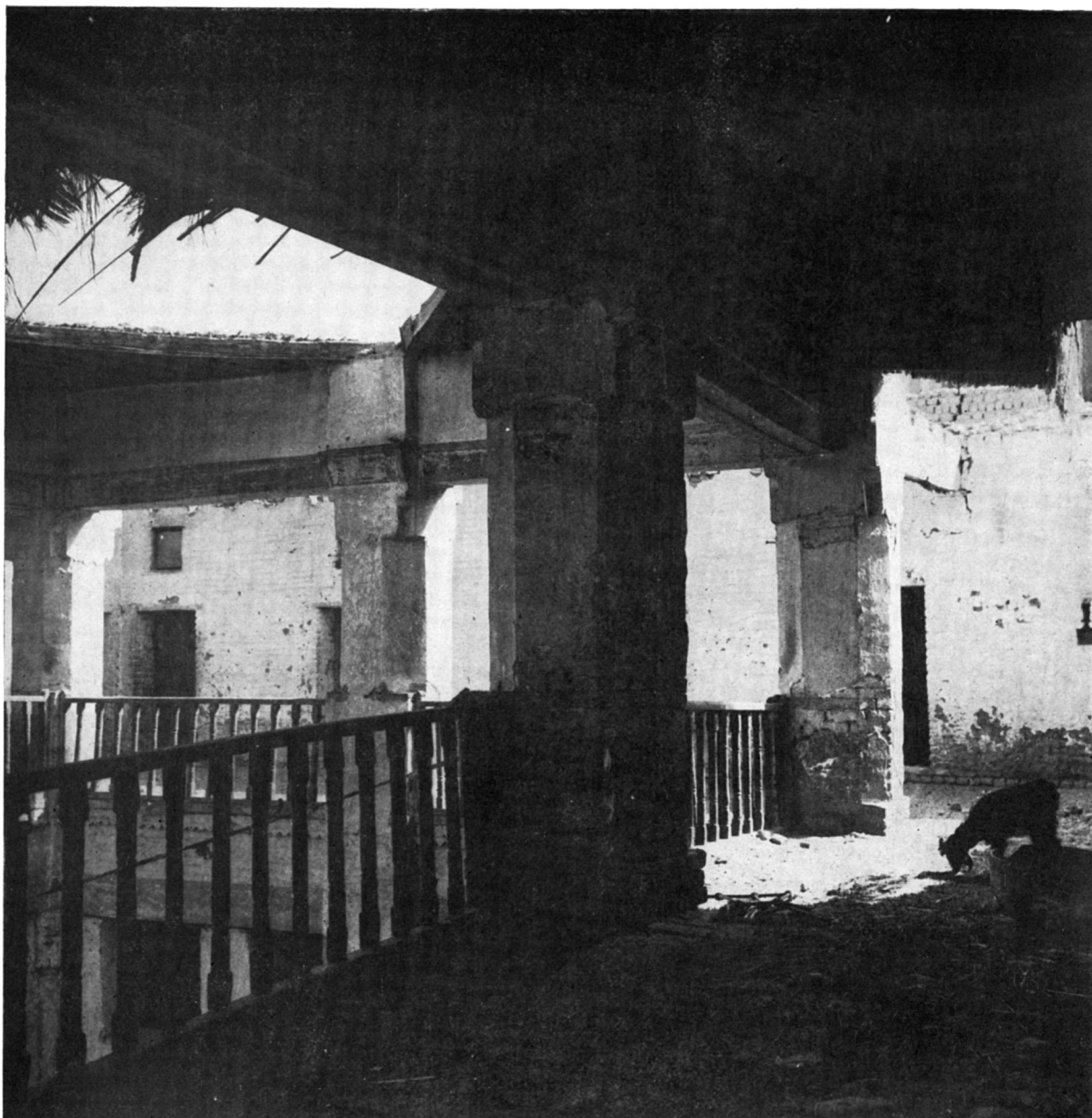
Galerie, vue générale.
