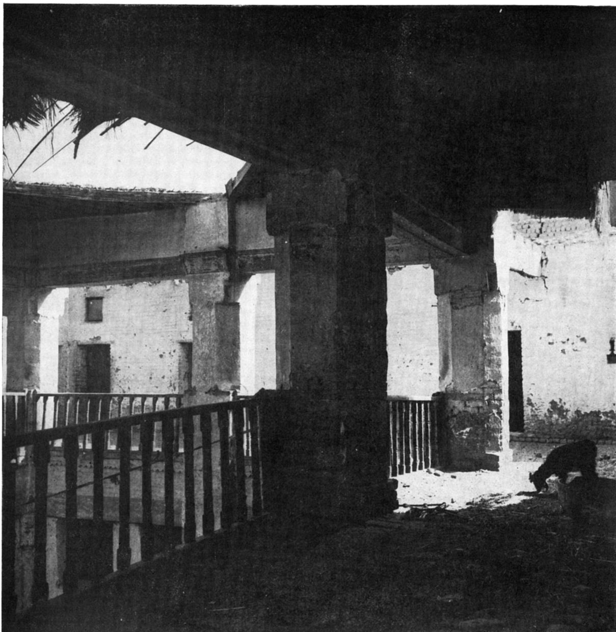
Galerie, vue générale.
