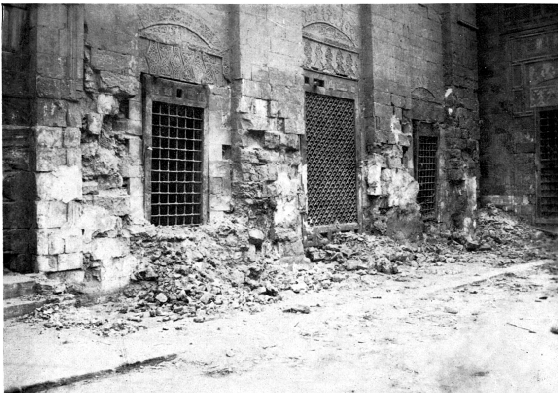
A. — La Madrasa Şālihiyya Nağmiyya : état actuel (la façade).
